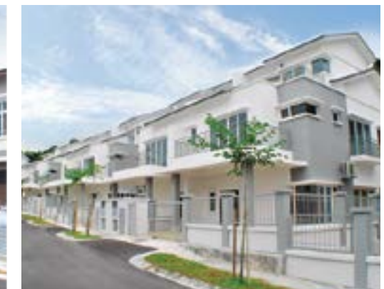
Tiaraville - 34 座 2 层半的半独立式洋房，室内布局别具一格
