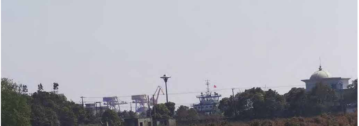
图 3.2-18 海门市沿江堤防生态公益林现场图片
