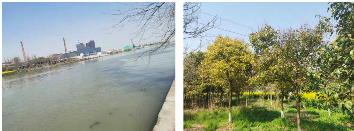
图3.2-16 通启运河（海门市）清水通道维护区现场图片
