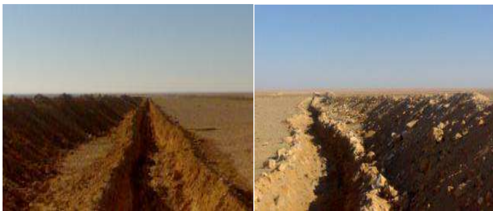
Рис. 4. Траншеи с бермами (отвалами песка)
