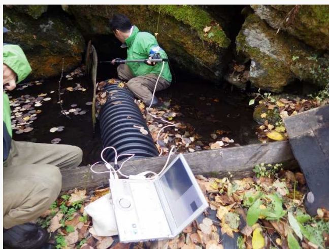
管内検査カメラによる確認
