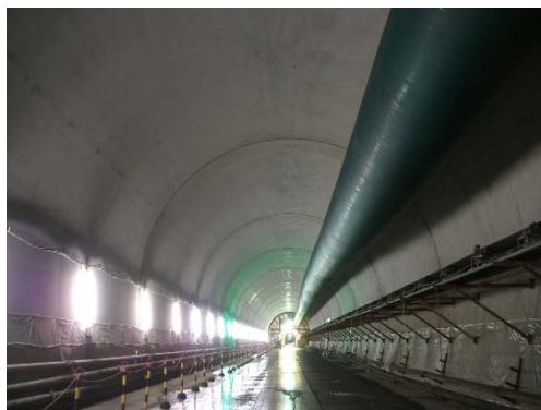
写真 5-1 渡島トンネル
