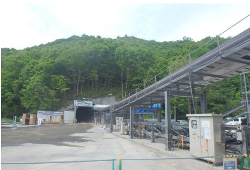
写真 5-4 後志トンネル
