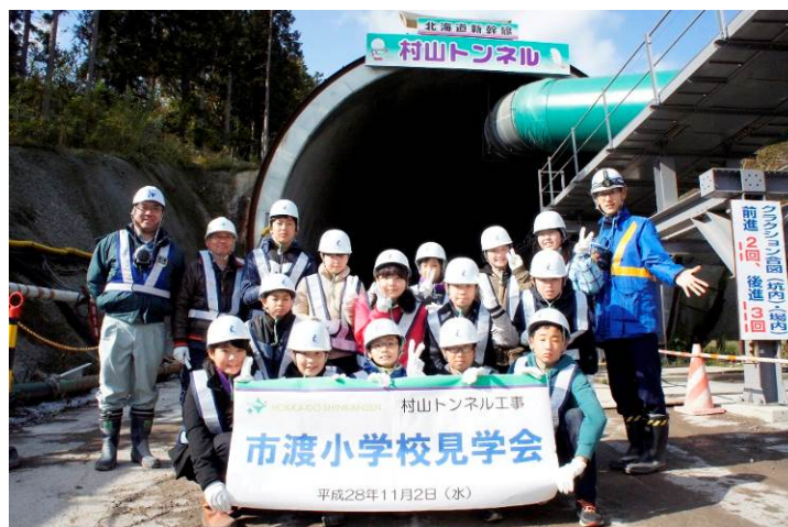
写真 5-17 地元小学校の現場見学会の様子（村山トンネル）
