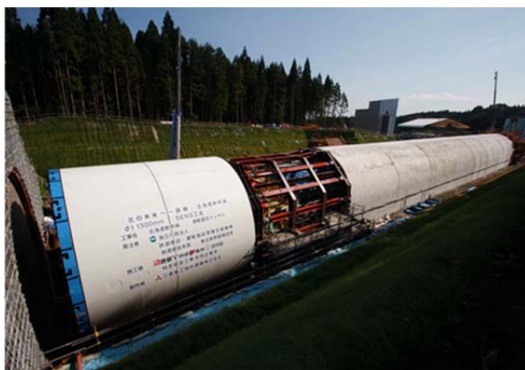
写真 5-7 シールドマシン (津軽蓬田トンネルの例)
