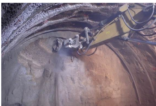
写真 5-3 昆布トンネル
