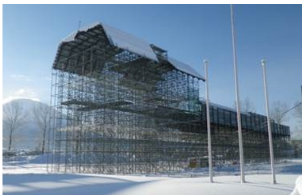
写真 5-5 実物大の模擬高架橋
