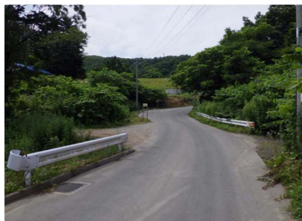
写真 5-9 工事用道路の様子
