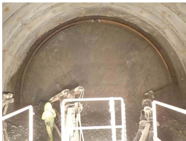
写真 5-12 吹付コンクリート（写真上部）
