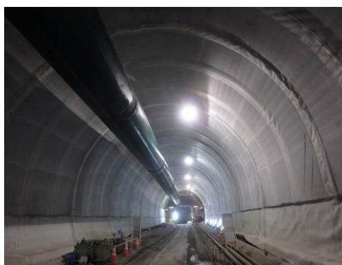
写真 5-2 立岩トンネル
