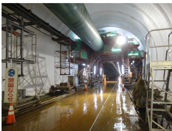
写真 5-11 昆布トンネル
