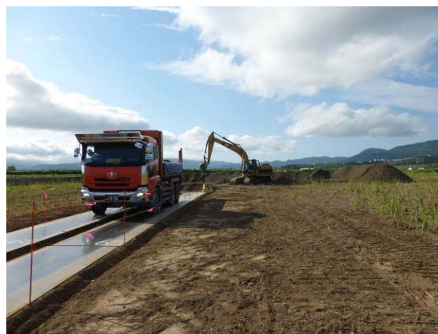
写真 5-8 土地造成の様子
