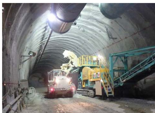
写真 5-14 ベルトコンベア方式
