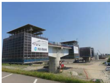
写真 5-2 手取川橋りょう
