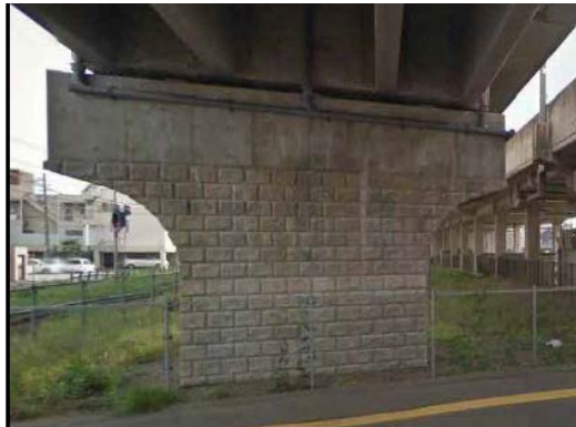
写真 5-10 日の出架道橋
