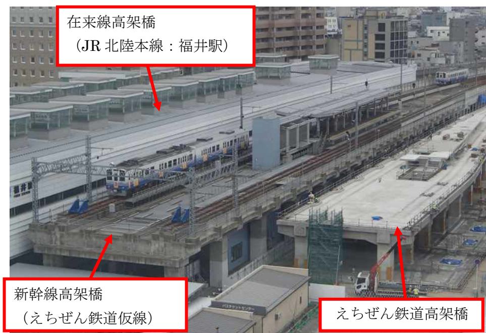
写真 5-5 福井駅立体交差事業
