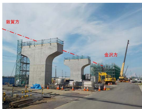
写真 5-3 川北橋高架橋
