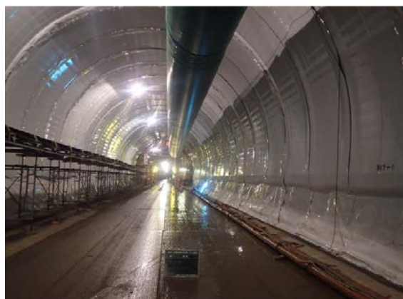
写真 5-6 新北陸トンネル
