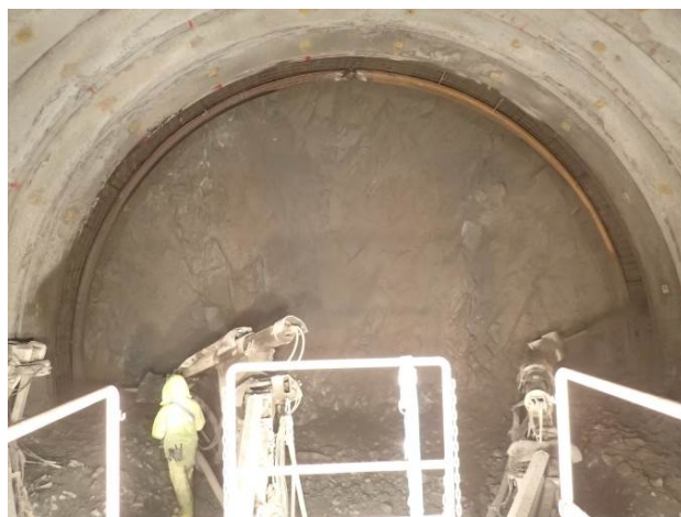
写真 5-7 吹付コンクリート（写真上部）
