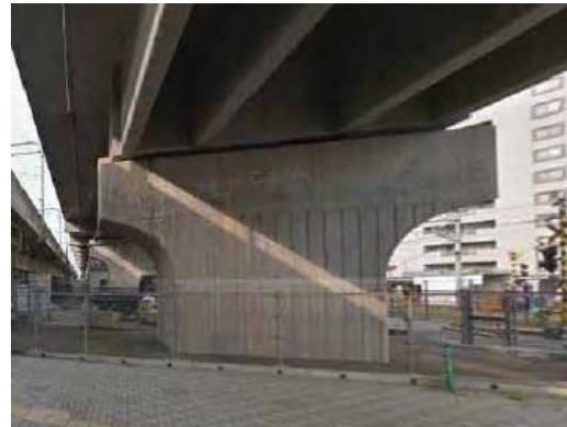
写真 5-11 第 4 大手架道橋
