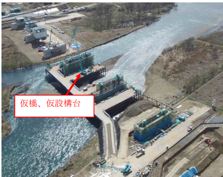
写真 5-8 九頭竜川橋りょう(仮橋、仮設構台)
