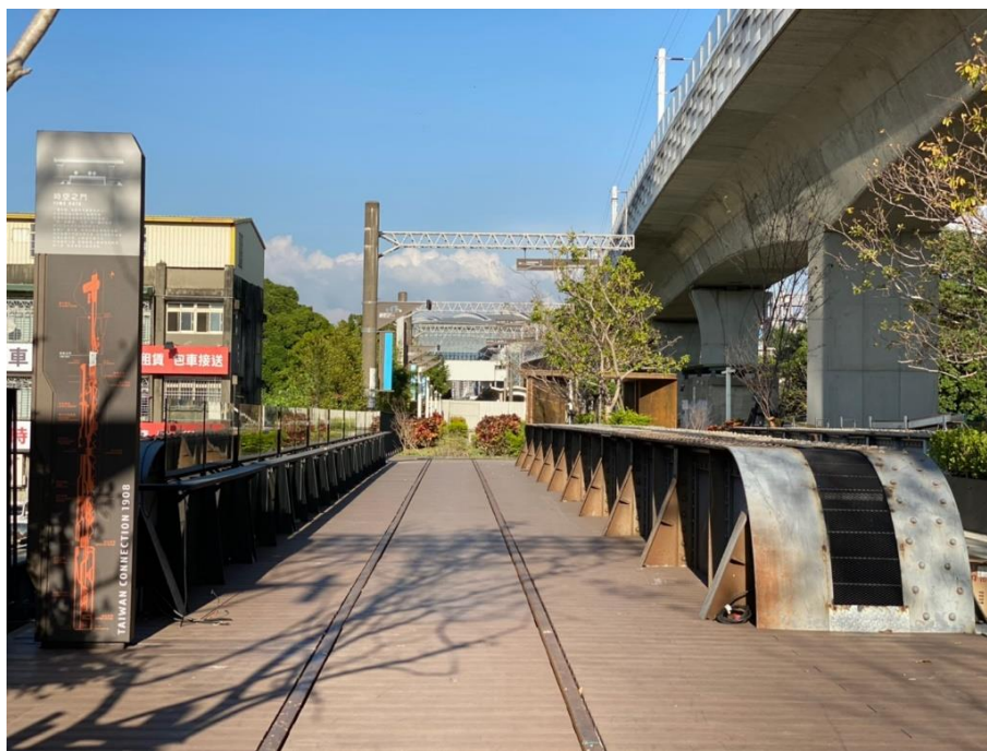
圖 4-1 南段完工照片 1
