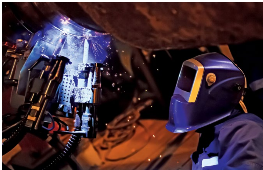
Зварювання трубопроводів під водою
