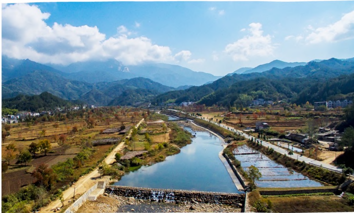
罗田山洪沟治理工程
