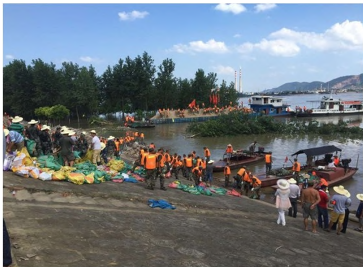
长江干堤滹水团林崩岸抢险
