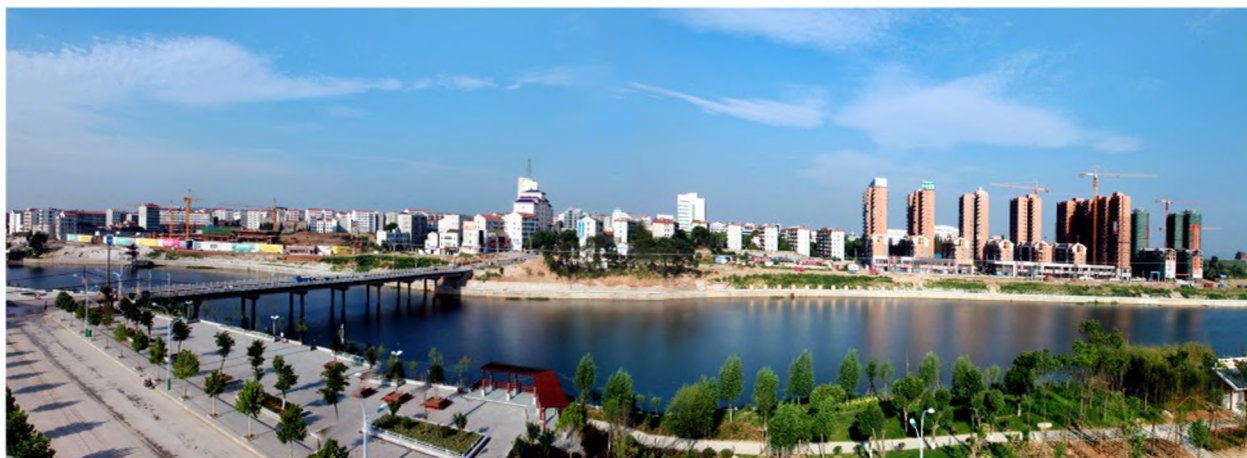
红安倒水河治理工程
