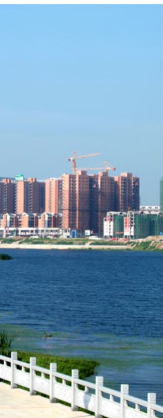
红安县倒水河综合整治工程
