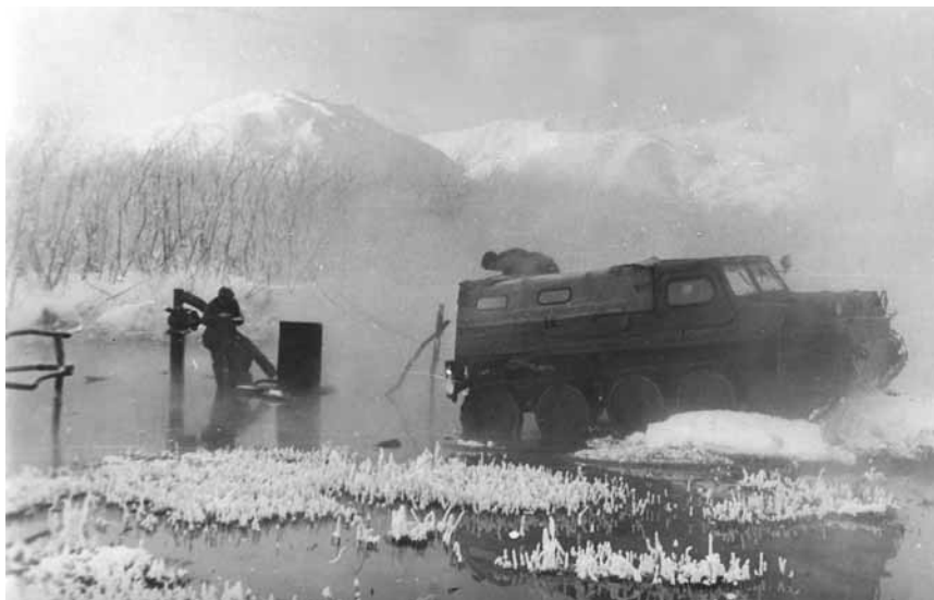
Сотрудники Отряда опробования замеряют расход воды в скважине (март 1968 г.)
