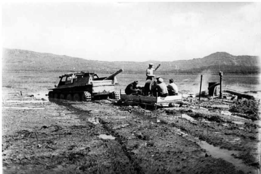
Термотермия скважины (измерение температуры воды по горизонтам) на Паратунской тундре (август 1968 г.)
