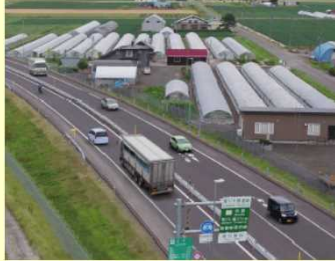
写真:旭川開発建設部
