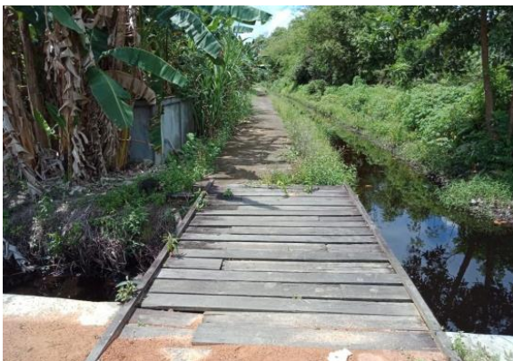
Jembatan menuju TPU RT 07
