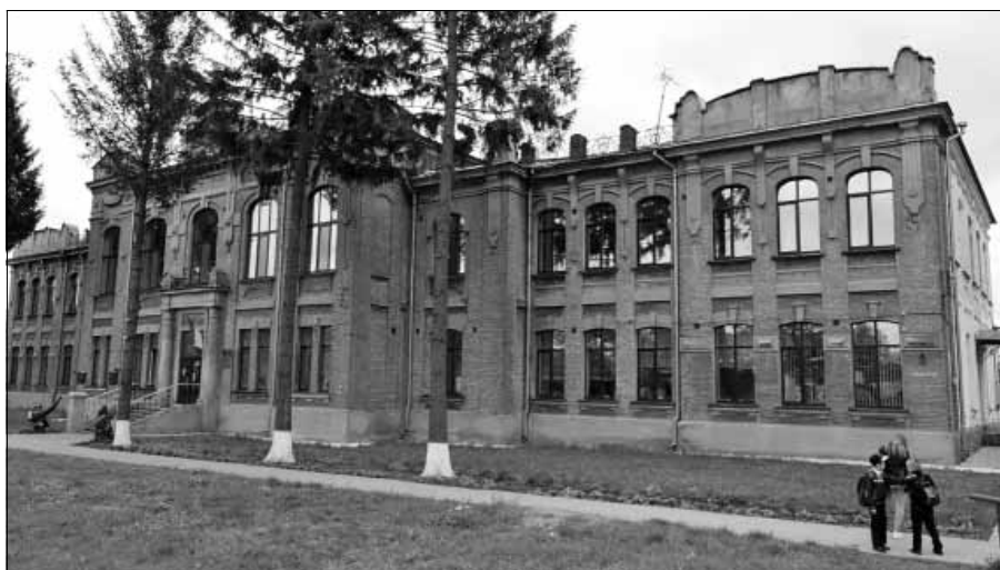
Рис. 7. Будівля чоловічої гімназії, 1914 р., вул. Воздвиженська, 20. Об'єкт культурної спадщини, що пропонується до взяття на державний облік за видом «архітектури»
