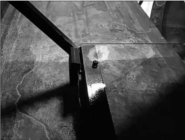
Рис. 1. Розміщення пофарбованого датчика на металевій стійці огородження
