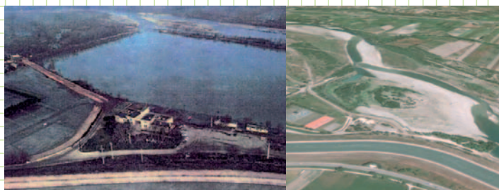
Digue du camping à La Roque d'Anthéron. Le même endroit aujourd'hui qui a rompu lors de la crue de 1994....
