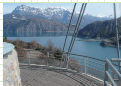
La retenue de Serre-Ponçon, vue depuis le belvédère surplombant le barrage
