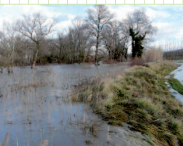
Débordement par-dessus une digue agricole à Charleval (13) lors de la crue de mai 2008
