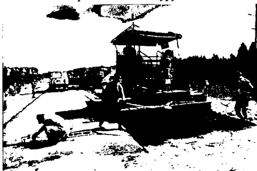
Ремонт дороги выполняет АСУ-1.
