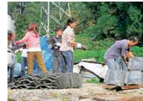
古民家修復作業 (北谷町小原)
