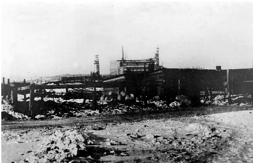
Комсомольская ТЭЦ-2 судостроительного завода № 199. г. Комсомольск-на-Амуре, 1941 г.
