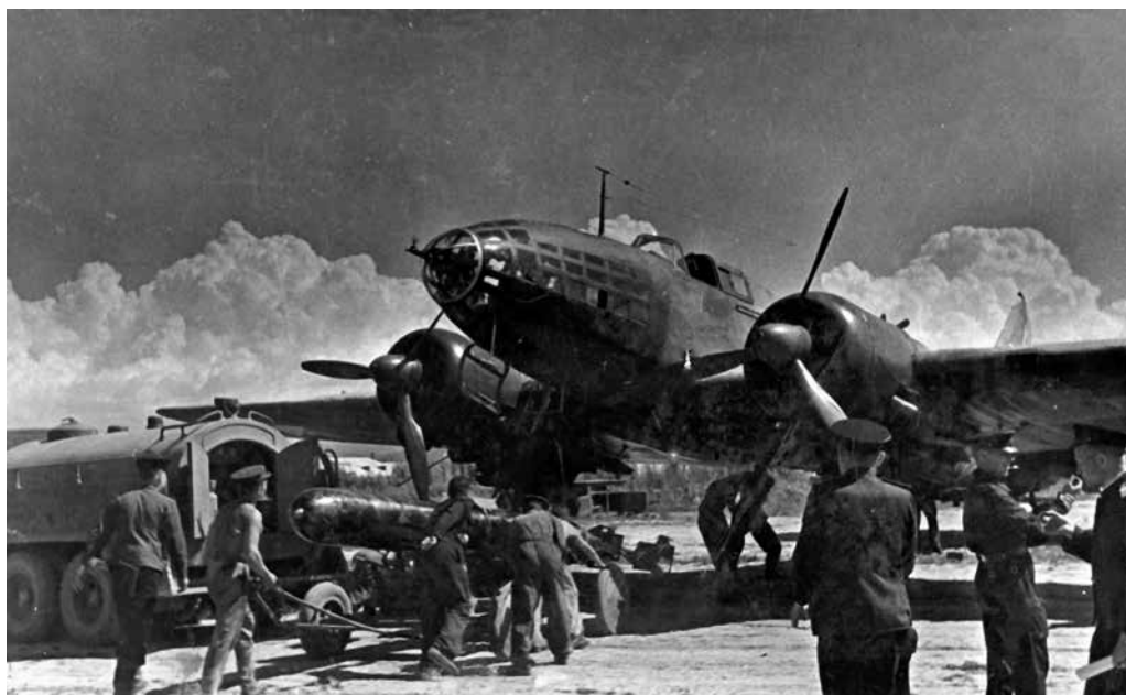
Подвеска торпеды к самолету Ил-4т минно-торпедной авиации Тихоокеанского флота. 1945 г.
