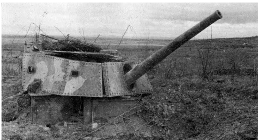
Хутоусский укрепленный район. Японское 150-мм орудие в бронебашенной установке, уничтоженное советской артиллерией. 1945 г.
