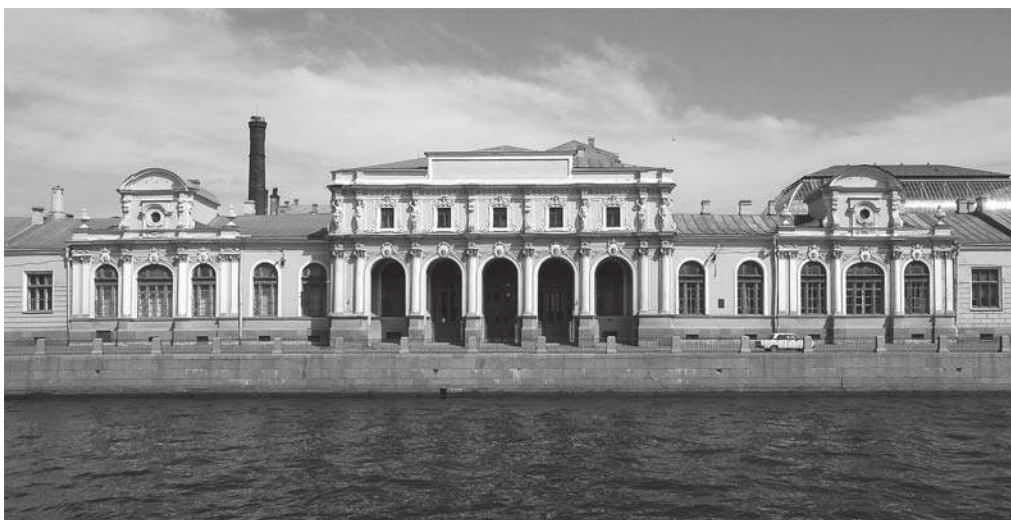
2. Л. Ф. Фонтана. Здание Мануфактурной выставки (перестройка бывшего Соляного городка). 1869–1870
