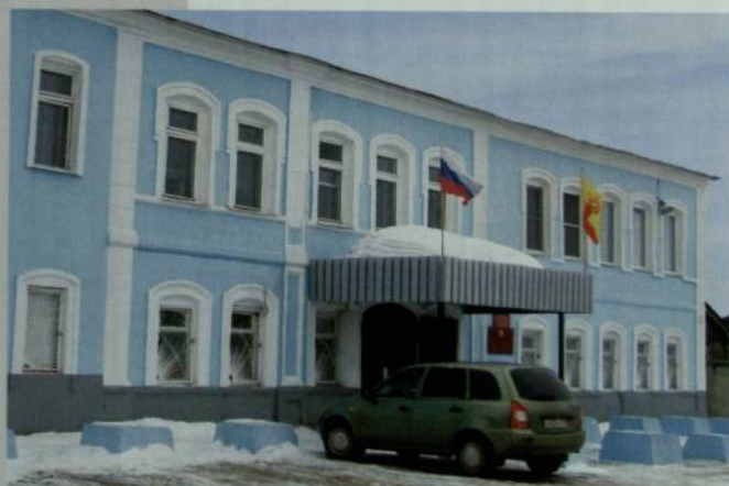
Общий вид здания. Фото 2012 г.
