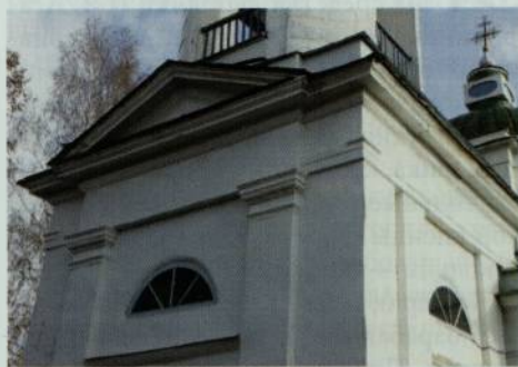
Фрагмент памятника. Вид с юго-западной стороны.
