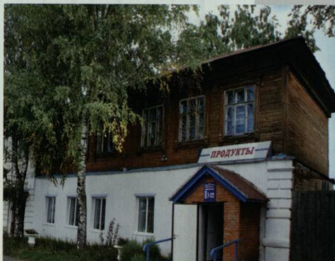
Общий вид здания. Фото 2012 г.
