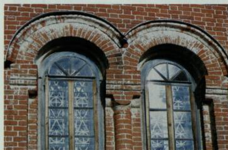
Фрагмент стены трапезной.
