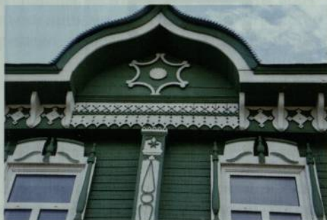
Фрагмент фасада. Элементы архитектурного декора.
