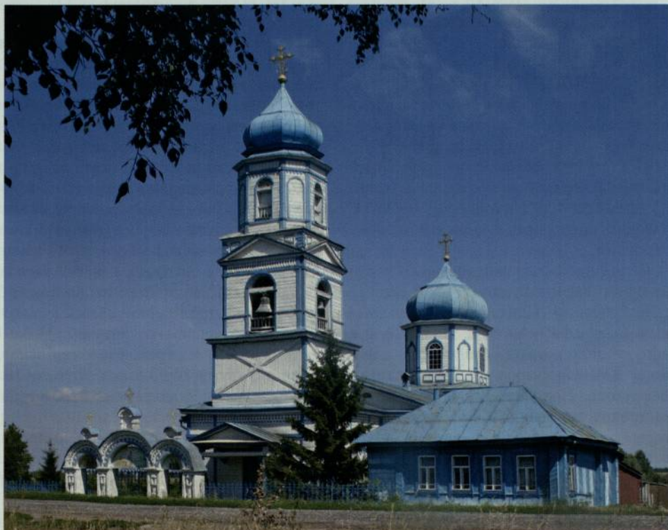
Богословская церковь. Фото 2012 г.
