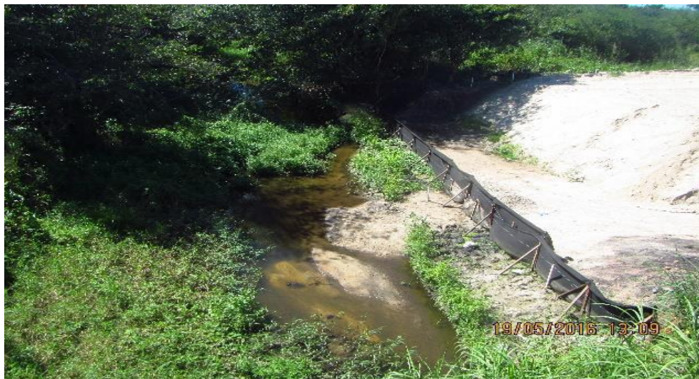
Figura 26. Leito do rio sob a ponte em processo de assoreamento.
