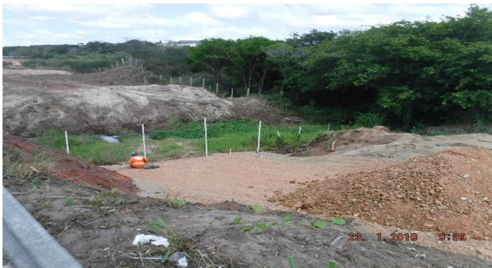
Figura 24. Implantação da barreira de siltagem as margens do rio Jundiáí.
