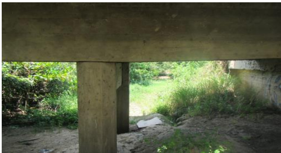
Figura 26. Leito do rio sob a ponte em processo de assoreamento.
