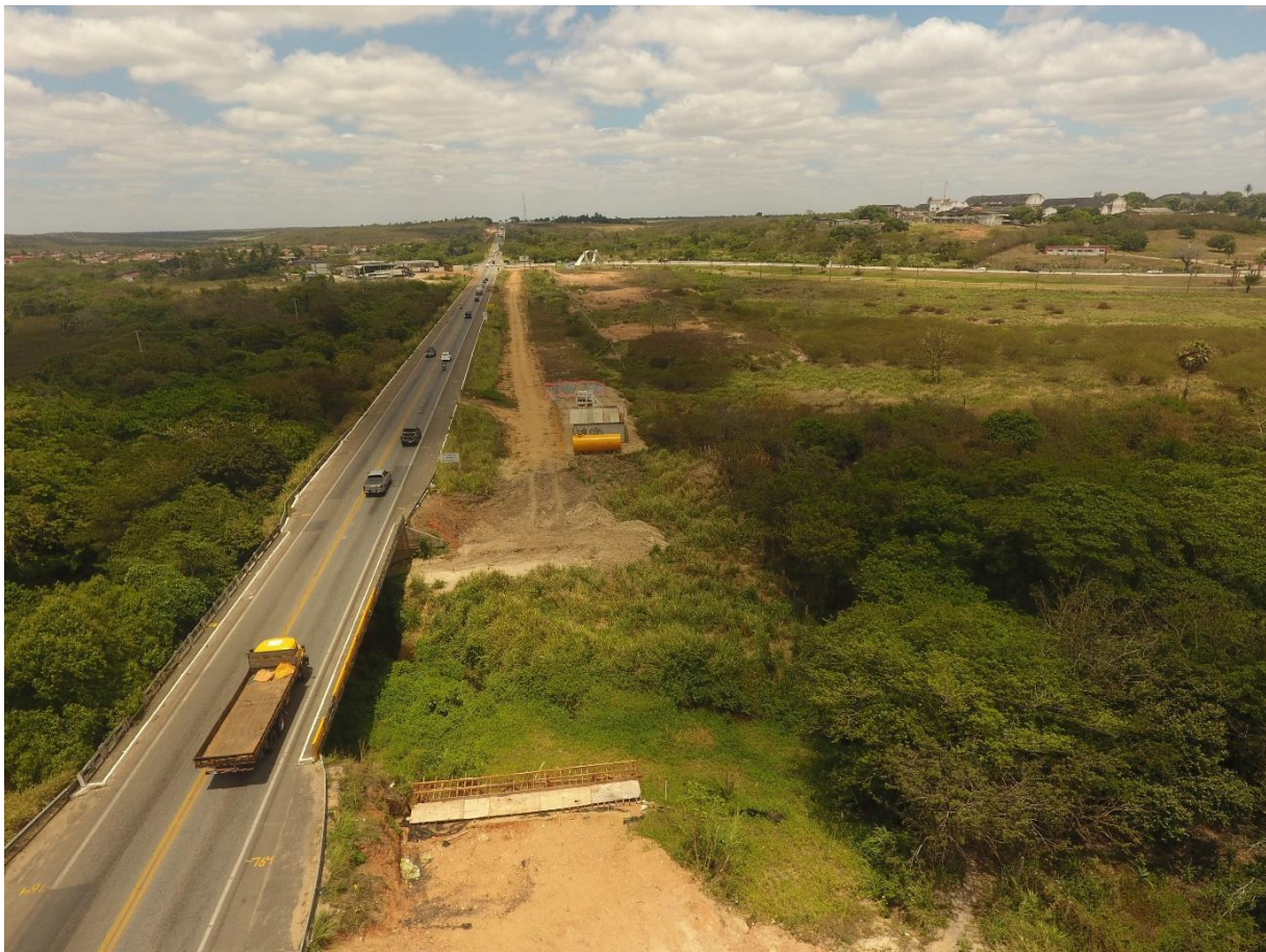
Figura 11. Visão Geral do trecho do rio Jundiá inserido na obra de duplicação da BR304/RN
