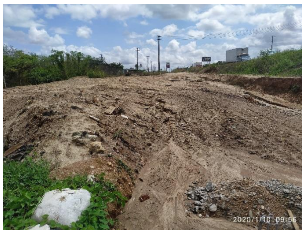
Figura 3. Material de solo escavado depositado para o preparo do subleito.
