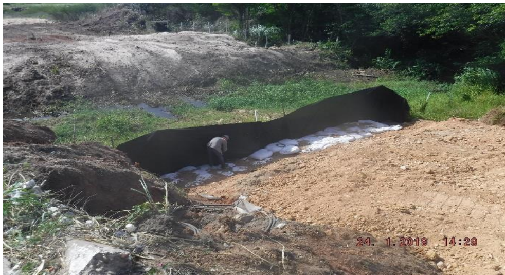
Figura 29. Acompanhamento do passivo ambiental e Implantação da barreira de siltagem. Data: 24/01/2019. Coord. (UTM): 239168/9351109.
