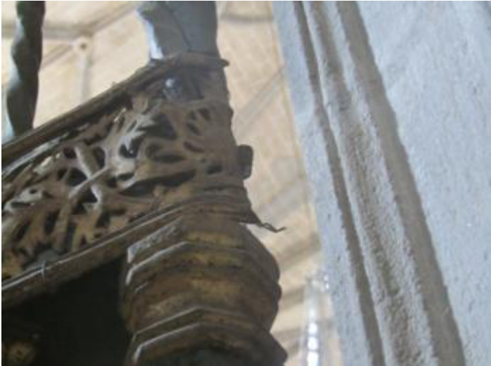
Fig. 5. Sujeción del friso a la reja del coro con alambres. En la imagen se aprecia el roleo del friso.
