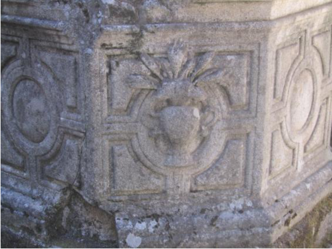
Fig. 25. Brocal del pozo lateral este.
