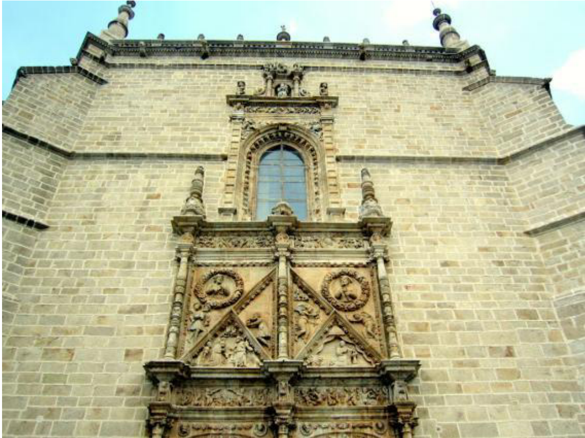
Fig. 5. Detalle del segundo, tercero y cuarto cuerpo de la Fachada Occidental.
