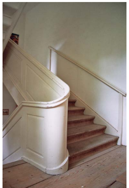
3.57 Stairs in Gnadau.
