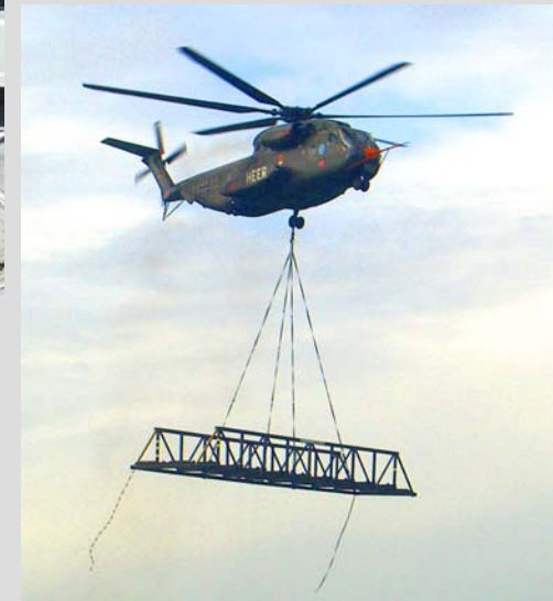
Heben mittels Hubschrauber (LBB-Brücke)
