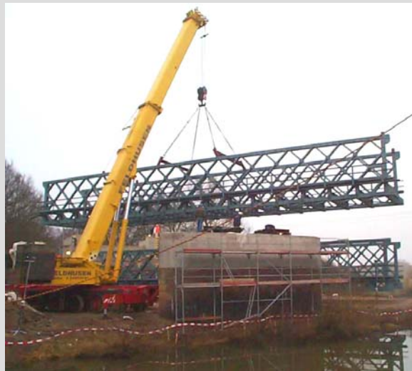
Einhub mit Mobilkran (SE-Brücke)
