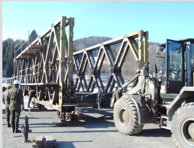
Einrollen über Rollenkästen (D-Brücke)
