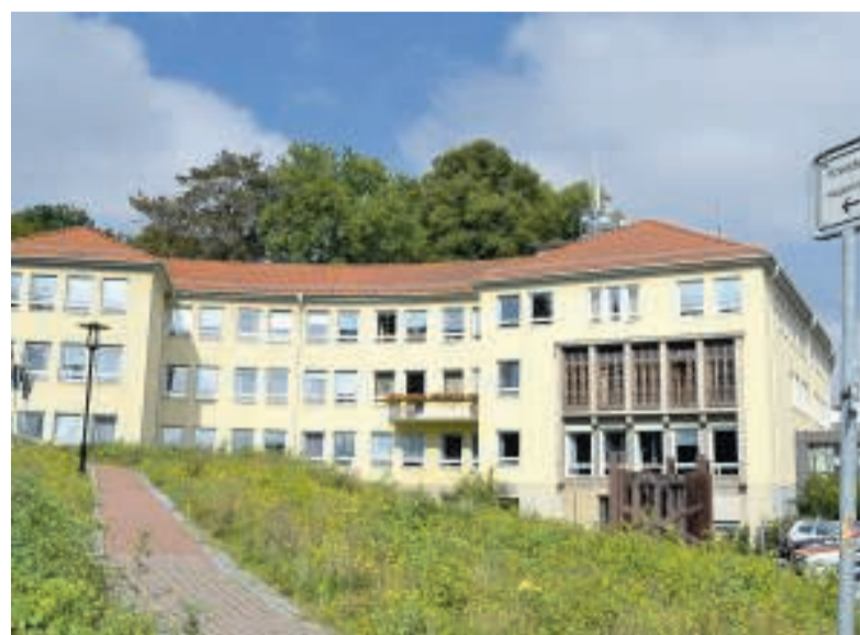
Der Streit um den geplanten Kreishaus-Anbau geht weiter: Während die Landkreisverwaltung diesen Hang bebauen will, lehnt die Stadt das aus Gründen des Bodendenkmalschutzes ab.
