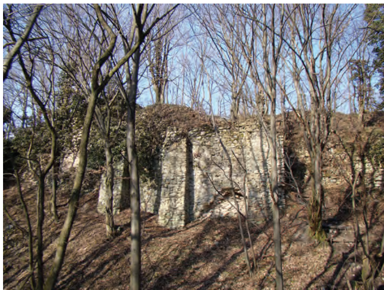
6. Oporné piliere južného opevnenia dolného hradu. Foto: František Gahér, 2010.
