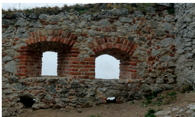
3. Renesančné strielne západného predhradia, stav pred a po obnove. Foto: Ján Barič.
