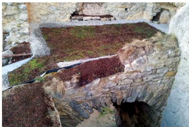
26. Skrytá strecha s vegetačnou úpravou na hrade Lietava (tzv. zelená strecha). Foto: Ľubomír Chobot, 2015.
