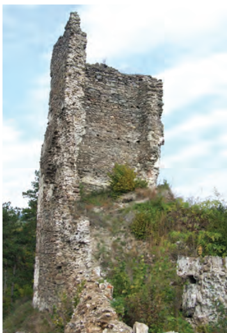
► 15. Hrad Revište. Stabilizácia vážne narušenej veže rekonštrukciou časti obvodovej steny s otvormi podľa dobových fotografií. V hornej časti je osadená skrytá vyhliadková plošina. Foto: Martin Bóna, 2012 a Michal Šimkovic, 2019.
