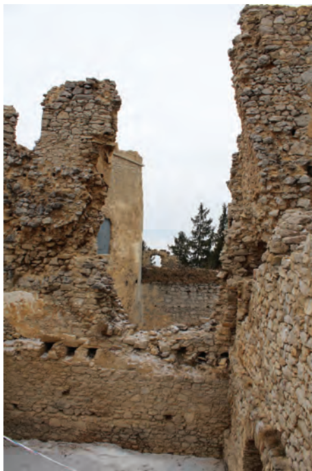
▲► 14. Hrad Lietava. Stabilizácia ohrozenej časti hradnej kuchyne obnovou deštruovanej steny s dymníkom. Stav v roku 1973 pred deštrukciou, v roku 2012 pred obnovou a v roku 2017 po obnove. Foto: SURPMO Olomouc a Michal Šimkovic, 2012 a 2017.
