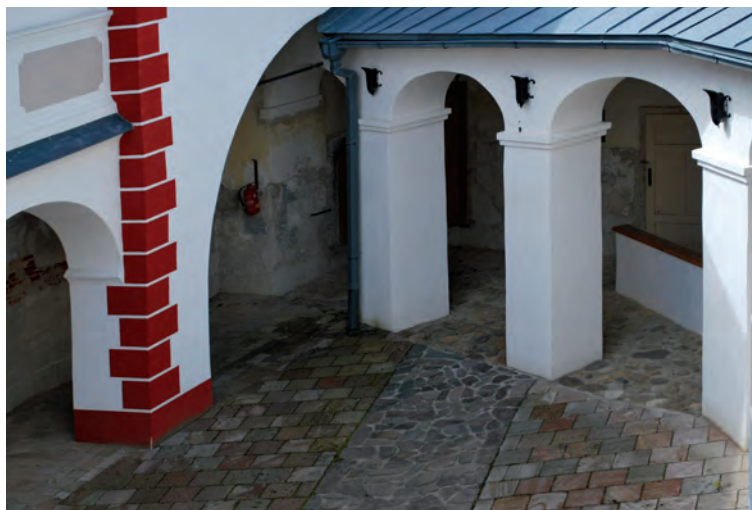
11. Analytická prezentácia okruhliakovej dlažby v novotvare dláždenia prezentujúceho barokovú etapu. Foto: Martin Miňo.
