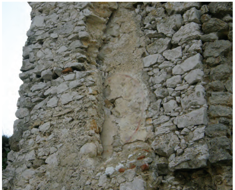
12. Hrad Čachtice. Deštrukcia primurovky odkryla časť omietky s malbou. Foto: Michal Šimkovic, 2009.
