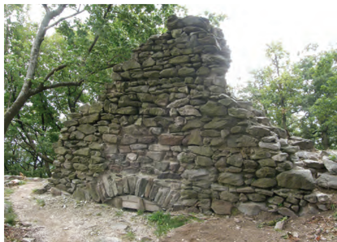
20. Čierny hrad. Príklad minimalistickej stabilizácie zachovanej steny veže. Foto: Michal Šimkovic, 2010.
