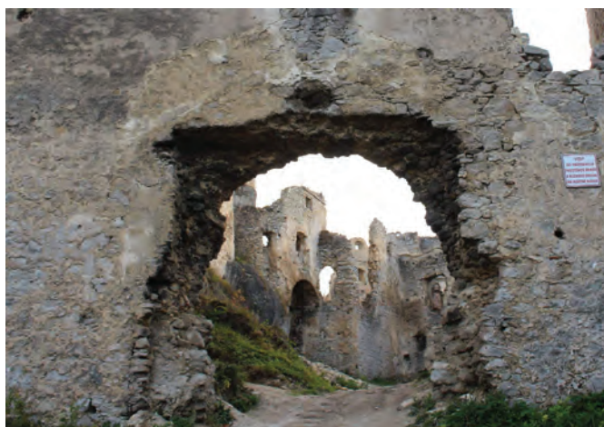
33. Stabilizácia narušenej brány bez doplnenia ostenia na hrade Lietava. Foto: Michal Šimkovic, 2013 a 2017.
