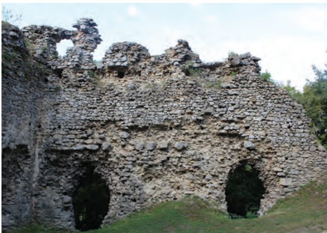
13. Príklad mimoriadne kvalitne zvládnutej obnovy veľkej plochy líca muríva na vstupnej bráne hradu Brekov. Foto: Michal Šimkovic, 2012 a 2015.
