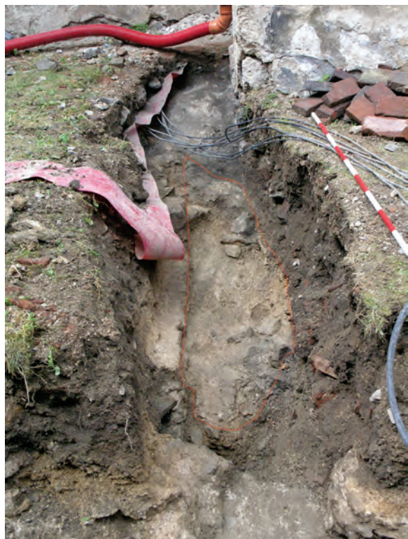
7. Najstaršia úprava nádvorja formou vyplnenia nerovností v brale vápennou maltou a lomovým kameňom. Foto: Martin Miňo.
