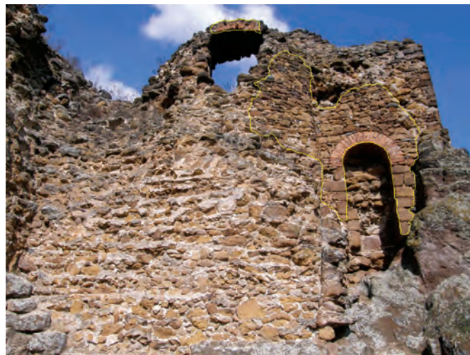
2. Filakovo, príklad kvalitne realizovanej stabilizácie muríva z konca 19. storočia. Označené sú obnovené úseky líca. Foto: Michal Šimkovic, 2010.
