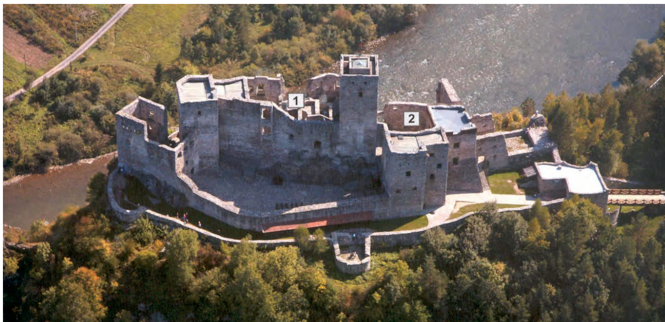
23. Letecký pohľad na hrad Strečno. Viditeľné sú skryté strechy realizované počas komplexnej obnovy hradu. Zdroj: CHROMEK, Peter – KOLLÁR, Daniel. Slovensko z oblakov. Flying over Slovakia. Hrady. Castles. Bratislava, 2009.
