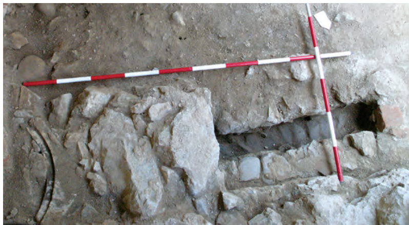
14. Renesančný kanálik slúžiaci na odvodnenie plochy horného nádvorja znefunkčnený pravdepodobne pri barokovej prestavbe. Foto: Martin Miňo.
