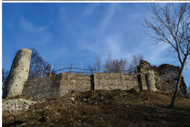
35. Hrad Vinné. Dobře realizovaná úprava terénu po archeologickom výskume pomocou gabiónových košov. Foto: Michal Šimkovic, 2012 a 2015.
