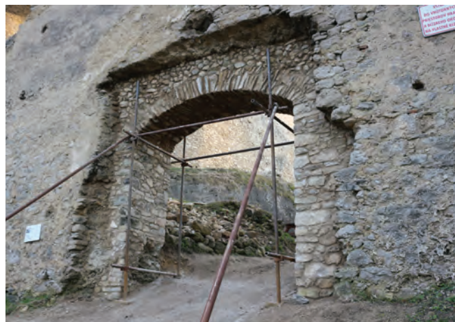
33. Stabilizácia narušenej brány bez doplnenia ostenia na hrade Lietava. Foto: Michal Šimkovic, 2013 a 2017.
