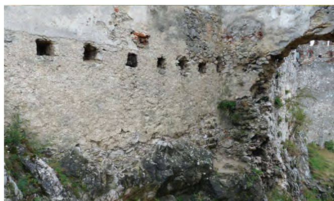
4. Bránová veža, východná stena, stav pred a po obnove. Foto: Ján Barič.
