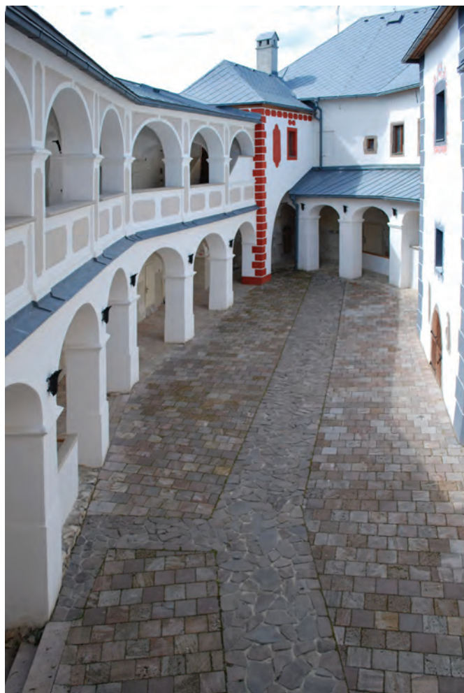
15. Horné nádvorie po obnove. Foto: Martin Miňo.
