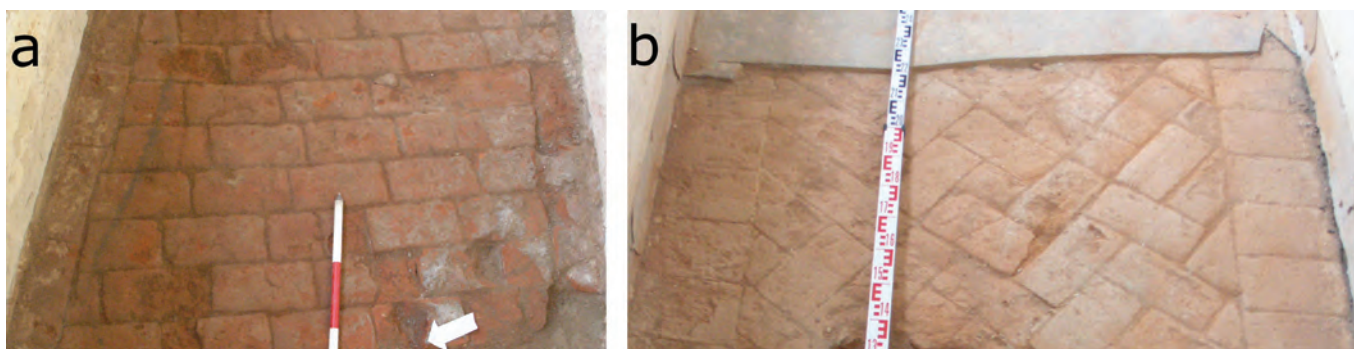
10. Dlažba z pálenej tehly v arkádach: a) na úrovni dvora, b) na poschodí. Foto: Martin Miňo a Zdenko Rusko.
