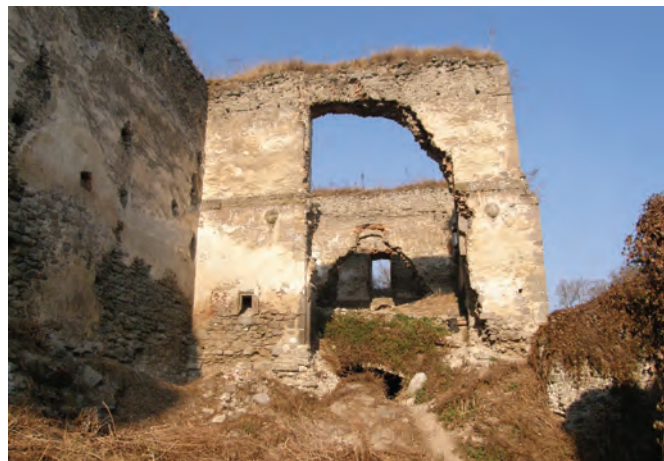
31. Rozsiahla deštrukcia portálu vstupnej brány na hrade Čabraď, ktorá vznikla vybraním ostenia portálu. Foto: Michal Šimkovic, 2011.
