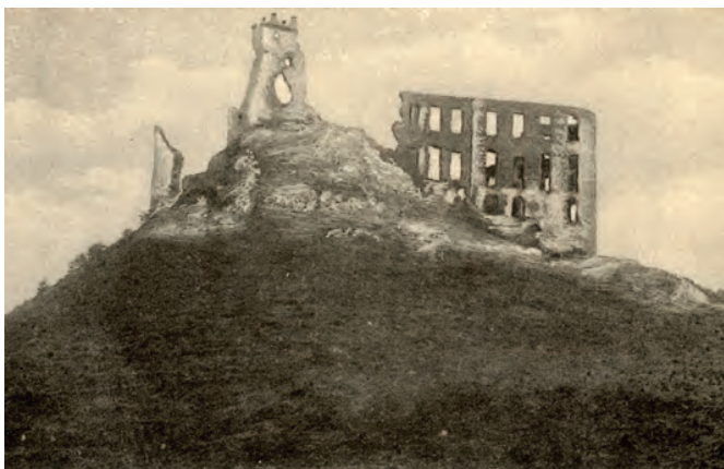
17. Porovnanie historickej pohľadnice hradu Plaveč a súčasného záberu dokumentuje zánik veľkých blokov muriva. Pre potrebu statickej stabilizácie je však potrebná rekonštrukcia len malej časti deštruovaných murív. Historická pohľadnica. Zdroj: SLÁMKA, Miroslav – PETRAKOVÍČ, Juraj – HORANSKÝ, Peter. Krajina hradov. Slovenské hradu na historických pohľadniach. Pezinok, 2010. Foto: Michal Šimkovic, 2008.
