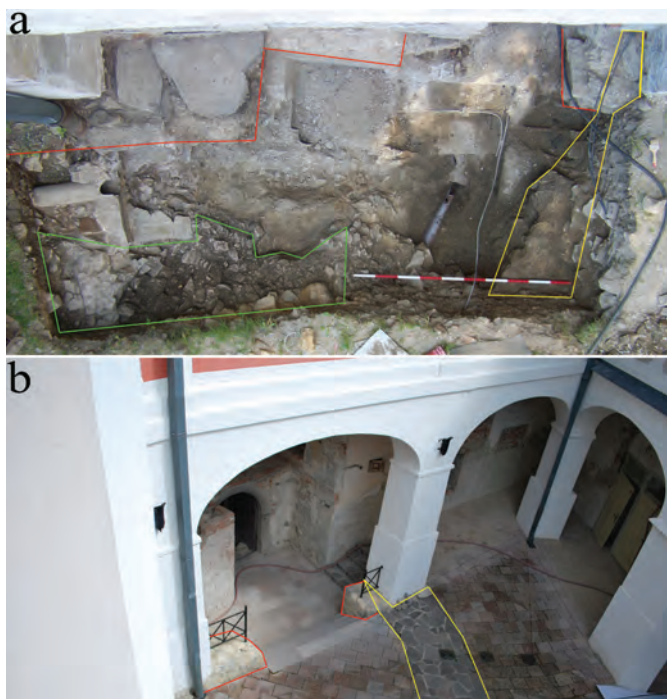
13. Situácia pri gotickom vstupe do nádvorja: a) nálezovalá situácia, b) po obnove. Farebne vyznačené: žltá – stredoveké murivá, červená – zachované časti základového pásu barokovej arkády, zelená – zachovaný stredoveký terén. Foto a úprava: Martin Miňo.
