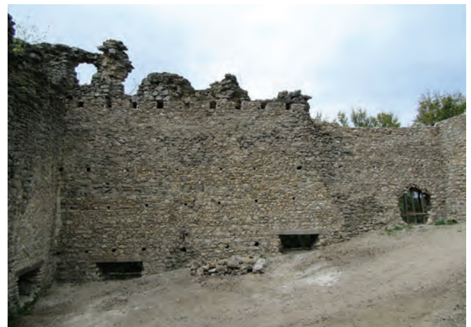
13. Príklad mimoriadne kvalitne zvládnutej obnovy veľkej plochy líca muríva na vstupnej bráne hradu Brekov. Foto: Michal Šimkovic, 2012 a 2015.
