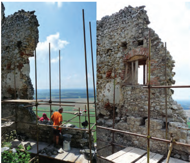
6. Bránová veža, západná stena bránovej veže, stav pred a po obnove. Foto: Ján Barič.
