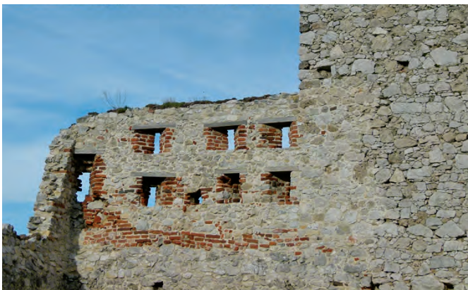
12. Západný úsek južného predhradia, stav pred a po obnove. Foto: Ján Barič.
