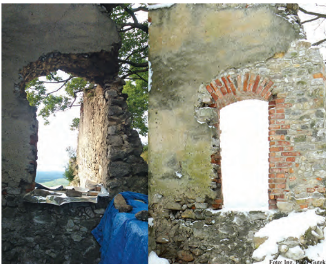
7. Palác západného predhradia, severná stena, stav pred a po obnove. Foto: Ján Barič, Peter Gutek.
