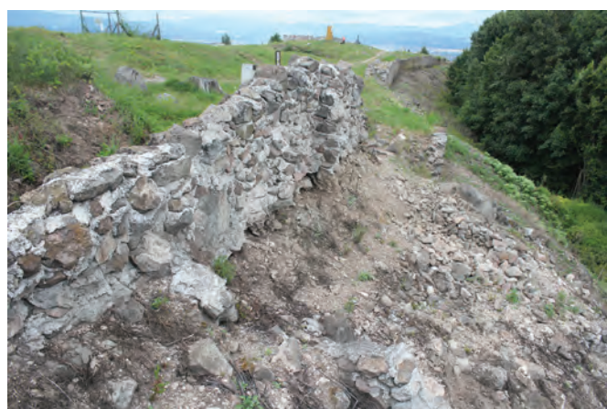
37. Zvolen, Pustý hrad. Deštrukcia hradby prezentovanej po odkrytí archeologickým výskumom. Foto: Michal Šimkovic, 2020.
