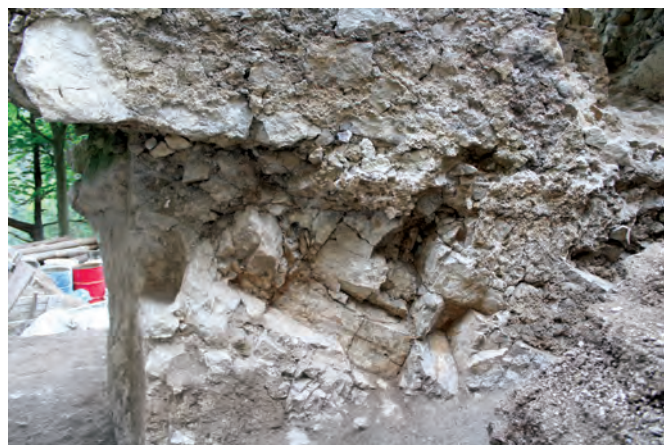
36. Hrad Blatnica. Detail založenia obvodových múrov na bralo, odkrytých archeologickým výskumom v paláci. Foto: Michal Šimkovic, 2015.
