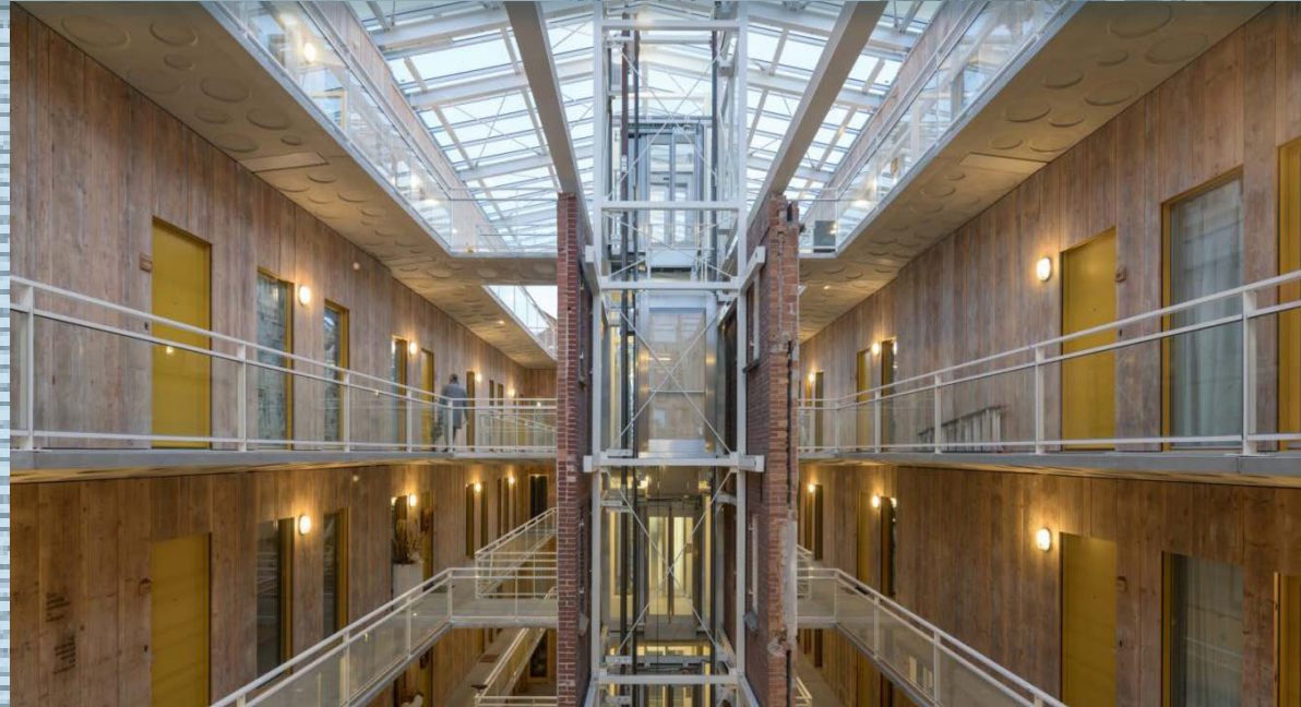
Loftwoningen in de panden van De Producent, centrale hal met de originele kaasplanken en een deel van de oorspronkelijke muren tussen de twee panden
