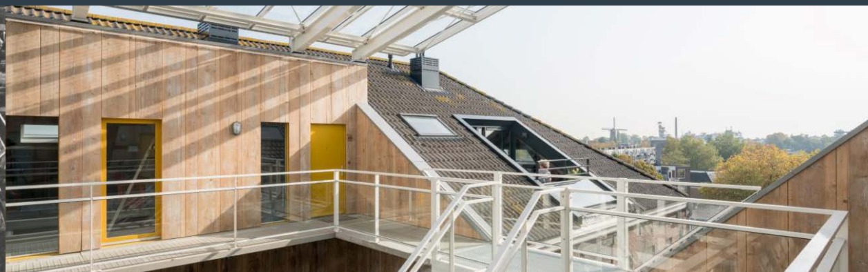
Loftwoningen in de voormalige panden van De Producent
