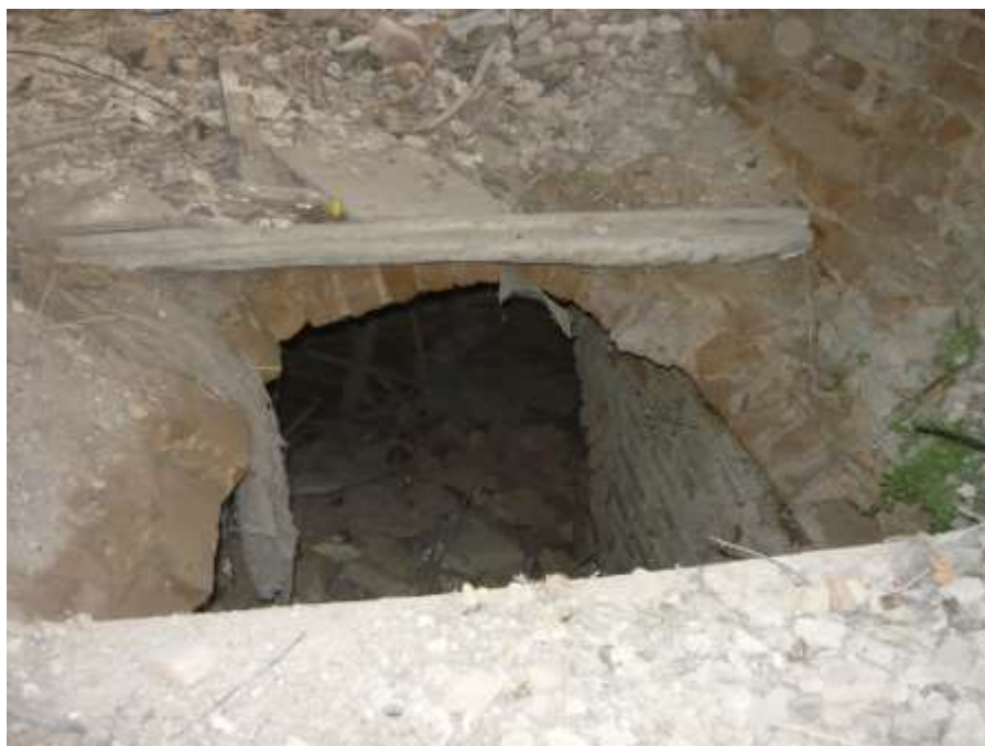
Zdjęcie 37 – Rok 2013, 25 sierpnia. Przebite przejścia do podziemi. Foto Mateusz Skórzewski.
