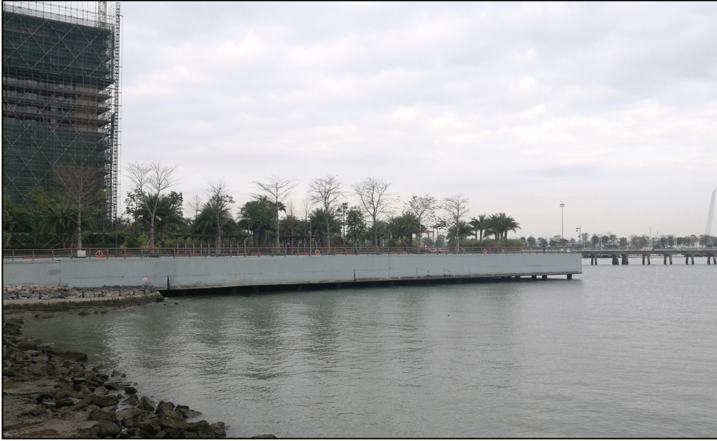
图 2.4-6 深圳湾滨海休闲带西段项目
