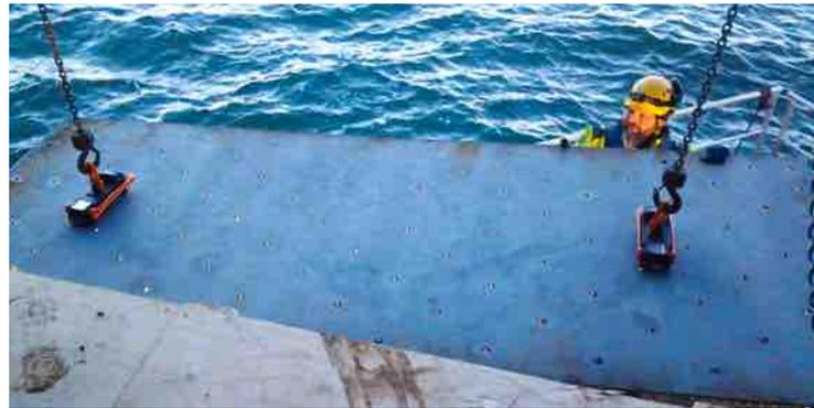
**HALT.** Zwei TML-250-Lasthebemagneten im Einsatz bei Reparaturarbeiten an der Lauttasaari Brücke in Helsinki.
