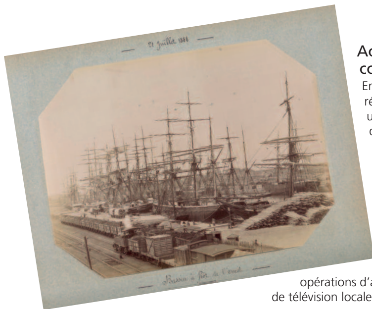
Album de photographies représentant la construction du port de Calais conservé dans le fonds de la chambre de commerce et d'industrie, collecté par les Archives municipales de Calais
