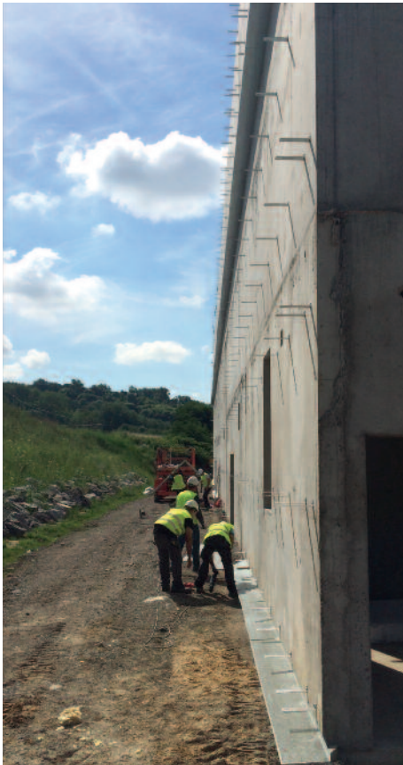
Chantier du bâtiment des Archives départementales de l'Aisne
