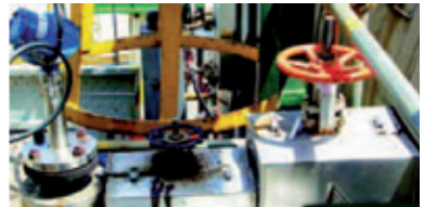
Волноводный радар Rosemount серии 5300, установленный на производственном участке
