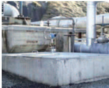
Rosemount серии 3300 надежно измеряет уровень и уровень границы раздела сред в зумпфах насосов
