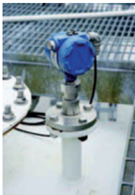
Rosemount серии 3300 с коаксиальным зондом подходит для работы в условиях тяжелых паров и конденсации.
