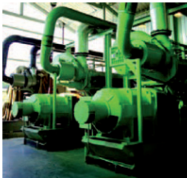
Типичные турбинные насосы, оснащенные собственной системой смазки
