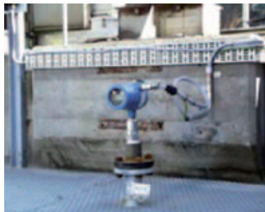
Rosemount серии 3300 надежно измеряет уровень и уровень границы раздела сред в зумпфах насосов
