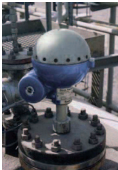
Радарный уровнемер Rosemount серии 5600, смонтированный с использованием фланца на крыше резервуара.
