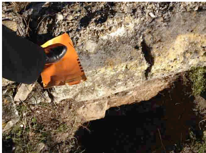
Première assise du parement méridional en place
