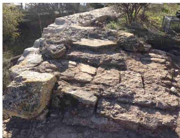
Soubassement de la vis d'escalier
