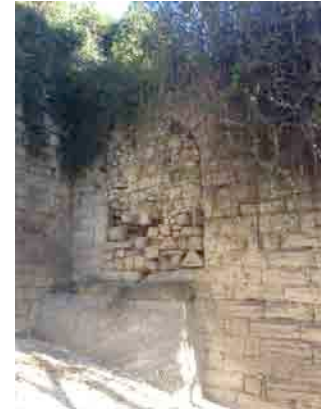
Porte murée s'ouvrant sud sous le jardin Serre
