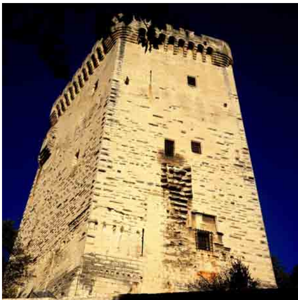
Arrachement en face orientale nié par une baie médiévale
