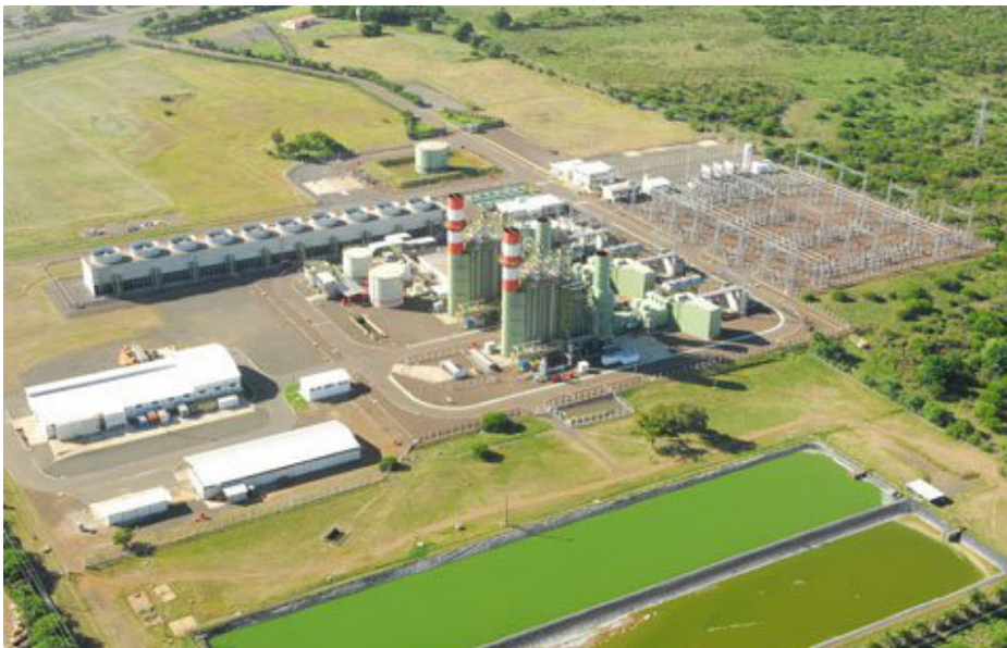
Figura 8 - Usina de Uruguiana operando 640 MW em ciclo combinado. Fonte: http://www.implicante.org/noticias/governo-recorre-a-termica-movidas-a-gas-transportado-pela-argentina-para-evitar-acionamento . Acesso em junho de 2016.
