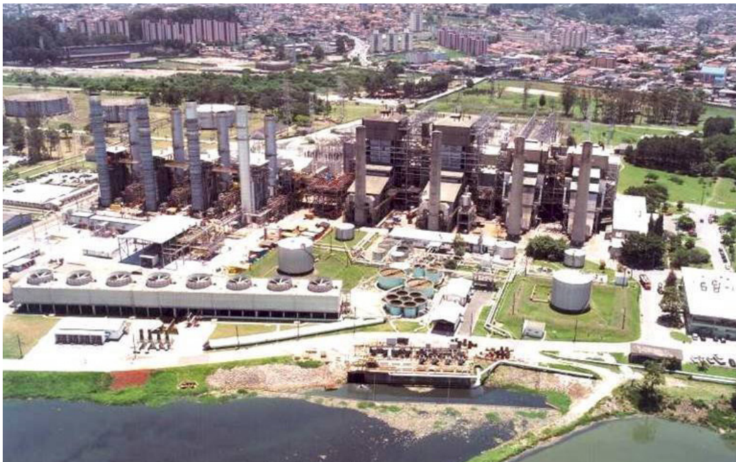
Figura 15 - Usina de Piratininga - São Paulo. Fonte: http://static.panoramio.com/photos/large/483491.jpg
