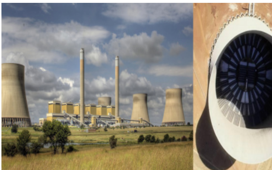
Figura 19 – Usina Termelétrica Kendal (4116 MW), África do Sul
