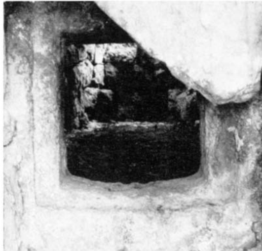
Fig. 86 - Alaior. "Naveta" Sud di Rafal Rubí. Lastrone perforato da portello con rincasso, che divide l'anticamera dalla camera, visto dall'anticamera.
