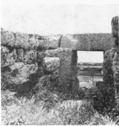
Fig. 90 - Mahón. "Talaiot" di Torellonet Vell. Porta a taglio trilitico nella parte superiore, vista dall'interno.
