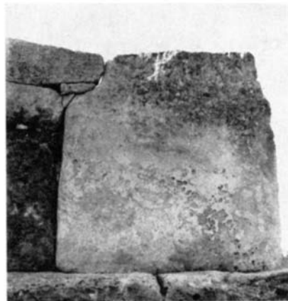
Fig. 68 - Malta. Tempio di Hagiar Kim. Ortostate all'estremità destra della facciata intagliato a incastro.
