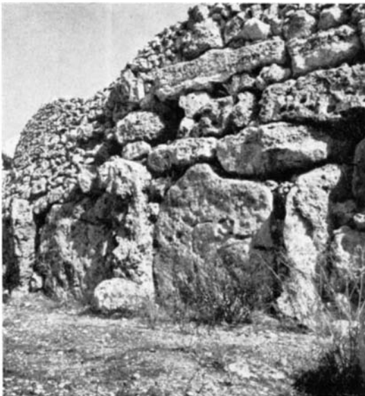
Fig. 53 - Gozo. Tempio Sud di Ggantija. Tratto del muro absidale a ortostati e filari.
