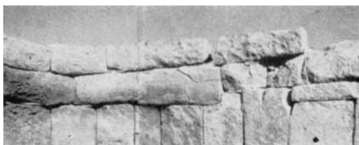
Fig. 69 - Malta. Tempio Sud di Hagiär Kim. Interno con lastra ortostatica tagliata a incastro per l'appoggio del filare.
