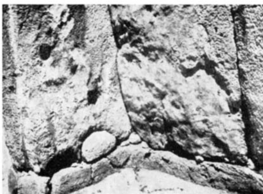
Fig. 100 - Malta, Tempio di Tarxien. Struttura ortostatica interna con pianetto d'appoggio.
