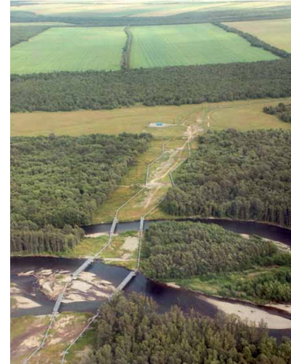
Рис. 3.37. Общий вид на технологический коридор трассы магистрального газопровода и воздушный двухниточный переход газопровода через долину Авачи (фото А. В. Улатова, 2010 г.)
