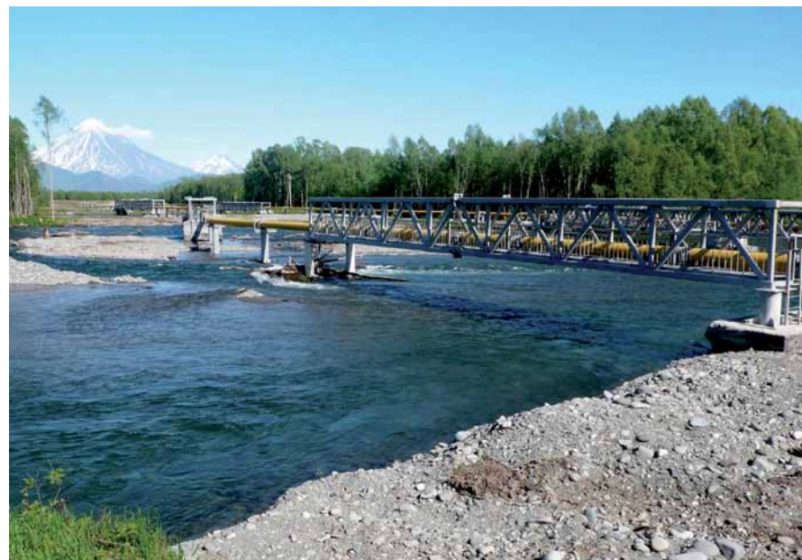
Рис. 3.42. Подсыпка крупным галечником низкой поймы для уменьшения размыва правого берега основного рукава (фото А.В. Улатова)
