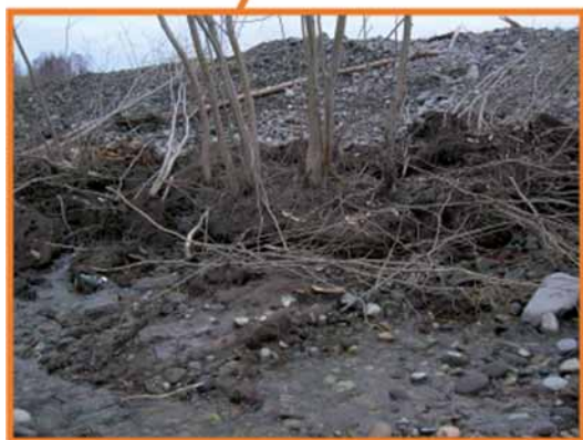
Рис. 3.27. Необоснованное создание насыпи для борьбы с размывами берегов и препятствия к активизации пойменных проток на р. Аваче (фото А.С. Чаловой)
