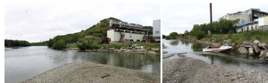
Рис. 3.54. Берегоукрепления правого берега р. Паланы в районе котельной (фото Е.В. Есина)
