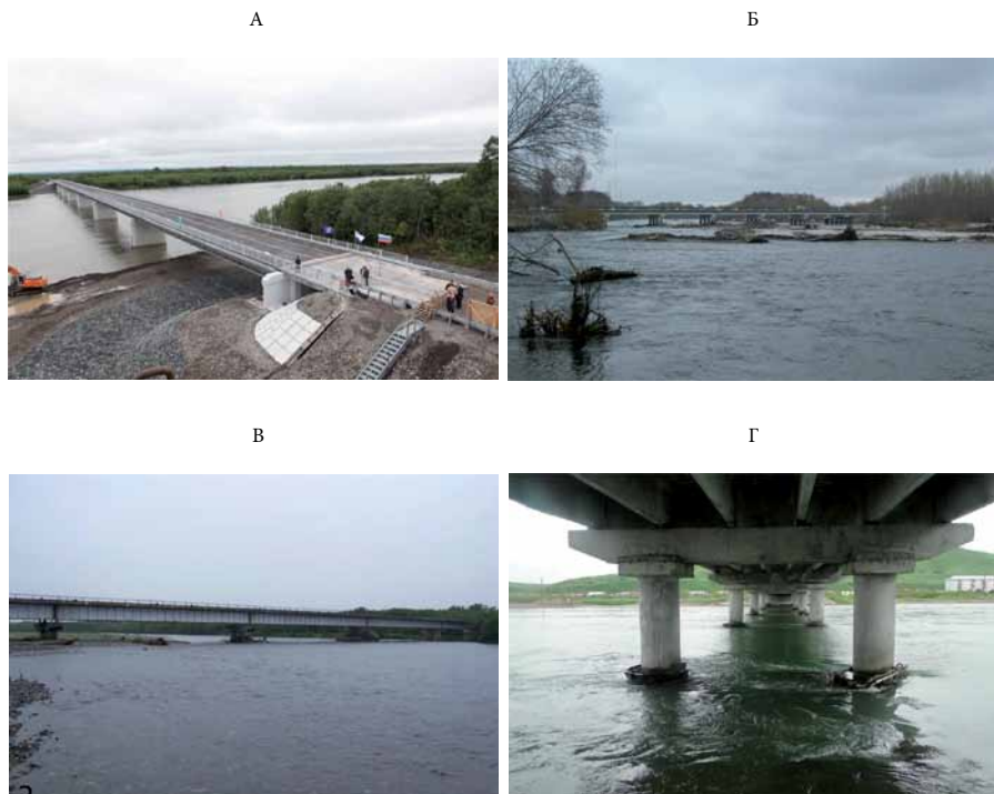
Рис. 3.3. Крупнейшие мостовые переходы через реки Камчатки: А – р. Камчатка (а/д Мильково – Ключи – Усть-Камчатск) (фото с сайта www.primamedia.ru ); Б – р. Авача (а/д Петропавловск-Камчатский – аэропорт) (фото С.Р. Чалова); В – р. Плотникова (а/д с-з Начикинский – с. Усть-Большерецк – пос. Октябрьский) (фото С.Р. Чалова); Г – р. Озёрная (а/д пос. Озерновский – пос. Запорожье) (фото Д.И. Школьного)
