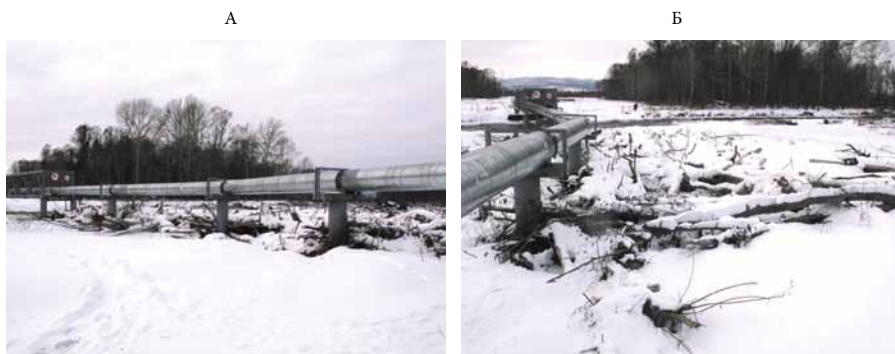
Рис. 3.44. Локальные древесные заломы, формирующиеся вокруг опор верхней нитки наземного перехода магистрального газопровода (фото А.С. Завадского, декабрь 2011 г.)
