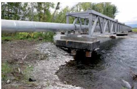
Рис. 3.40. Ферма надземного перехода одной из двух ниток магистрального газопровода через вторую по величине (на лето 2011 г.) протоку Авачи (фото А.В. Улатова)
