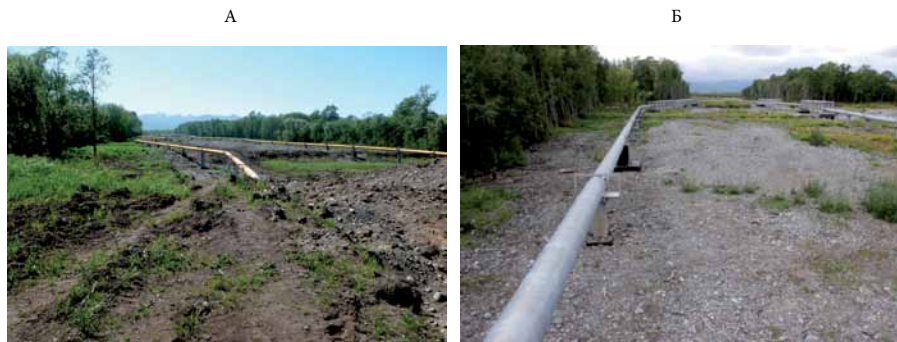
Рис. 3.38. Общий вид на участок технического коридора переход газопровода через долину Авачи: А — 2010 г.; Б — 2011 г. (фото А. В. Улатова)
