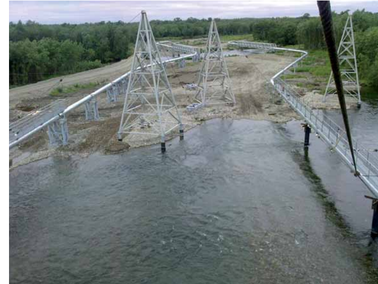
Рис. 3.16. Вантовый переход МГ через главную протоку р. Большой Воровской на ПК 652 + 63 (на переднем плане) и балочный переход МГ через протоку на ПК 650 + 87,9 (на заднем плане) в период окончания строительства (14.07.2010 г.) (фото А. В. Улатова)
