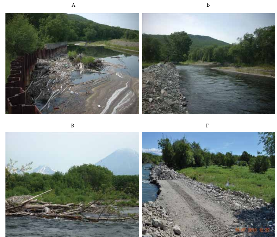
Рис. 3.33. Основные объекты и процессы, оказывающие влияние на режим поверхностных вод р. Авачи в районе Елизовского водозабора: А — шпунтовая стенка в истоке протоки 6 (фото С. Р. Чалова); Б — дамба 2 вдоль правого берега протоки 7 (фото С. Р. Чалова); В — перекрытие заломом истока протоки 7 (фото С. Р. Чалова); Г — размыв аварийной дамбы, созданной в период прохождения паводка 2013 г. по правому берегу протоки 7 (фото предоставлено Администрацией Елизовского муниципального района)
