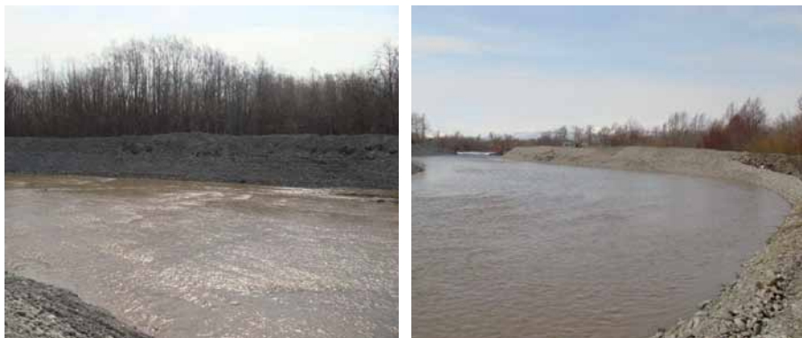
Рис. 3.60. Начало весеннего половодья 2008 г. — часть стока р. Авачи направлено в старичную протоку (из архива отдела архитектуры и градостроительства Администрации Елизовского муниципального района)
