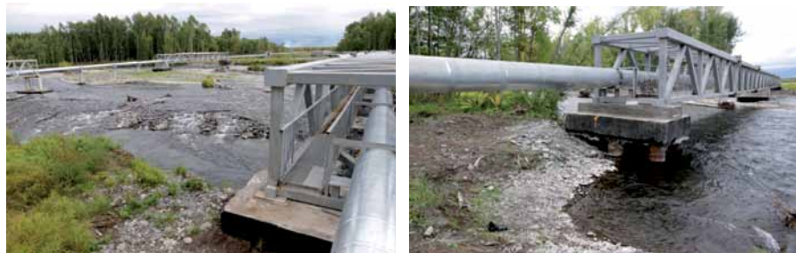
Рис. 3.39. Двухниточный воздушный переход трассы магистрального газопровода через вторую по величине и объёму стока (на лето 2011 г.) протоку Авачи (фото А.В. Улатова)
