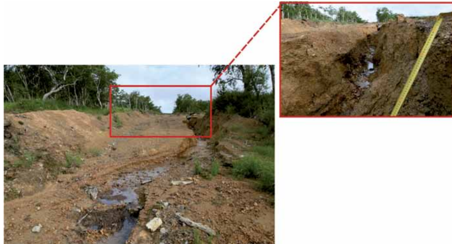
Рис. 3.20. Обнажение трубы в условиях развития ускоренной эрозии на склоне р. Чимистиной (фото А.В. Улатова, август 2011 г.)
