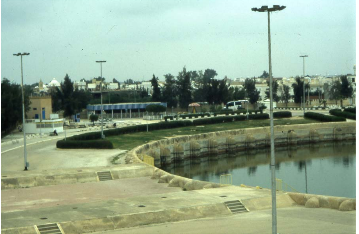
Grand bassin aghlabide : réserve et puisards
