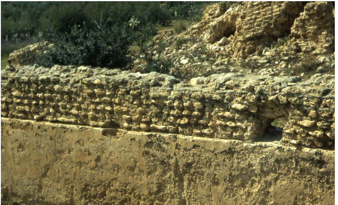
Construction en opus incertum au dessus du bassin à Haffouz
