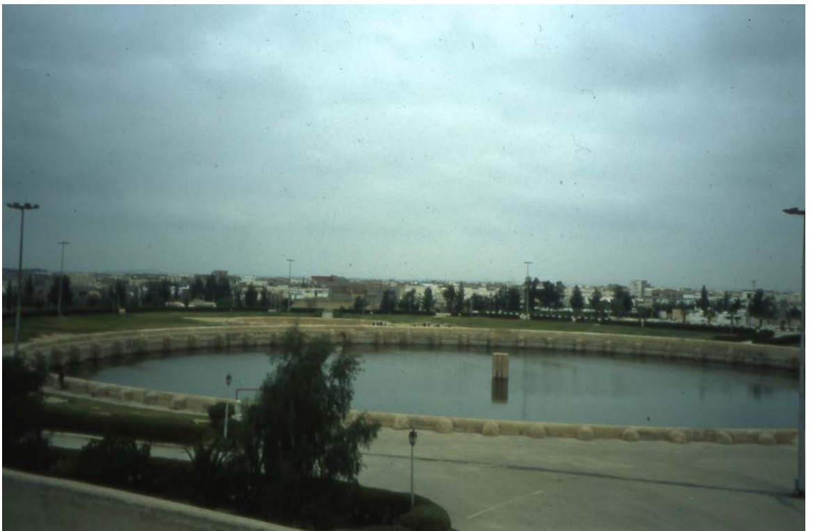
Grand bassin aghlabide : le bassin de réserve avec les restes de la tour centrale
