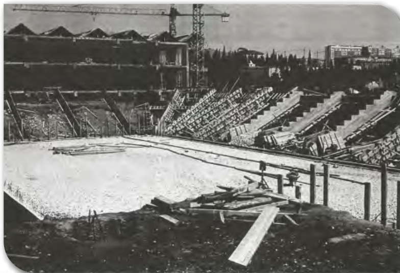
Dues imatges de la construcció del Palau Blaugrana.
