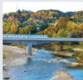
広瀬川橋りょう/3径間連続PRCラーメン橋 橋長172m 西公園高架橋/RCスラブ式CFT柱ラーメン橋 橋長118m
