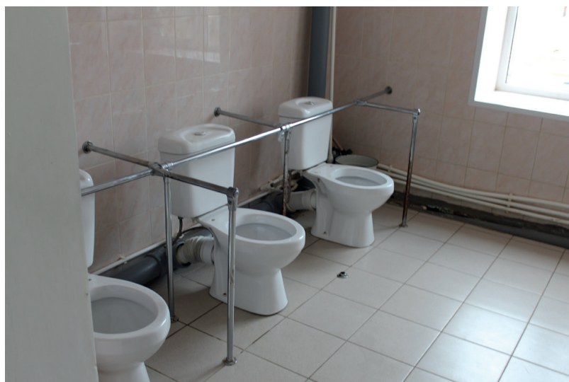
Туалет в одном из отделений ОГАУ «ШПИ» «Забота»
