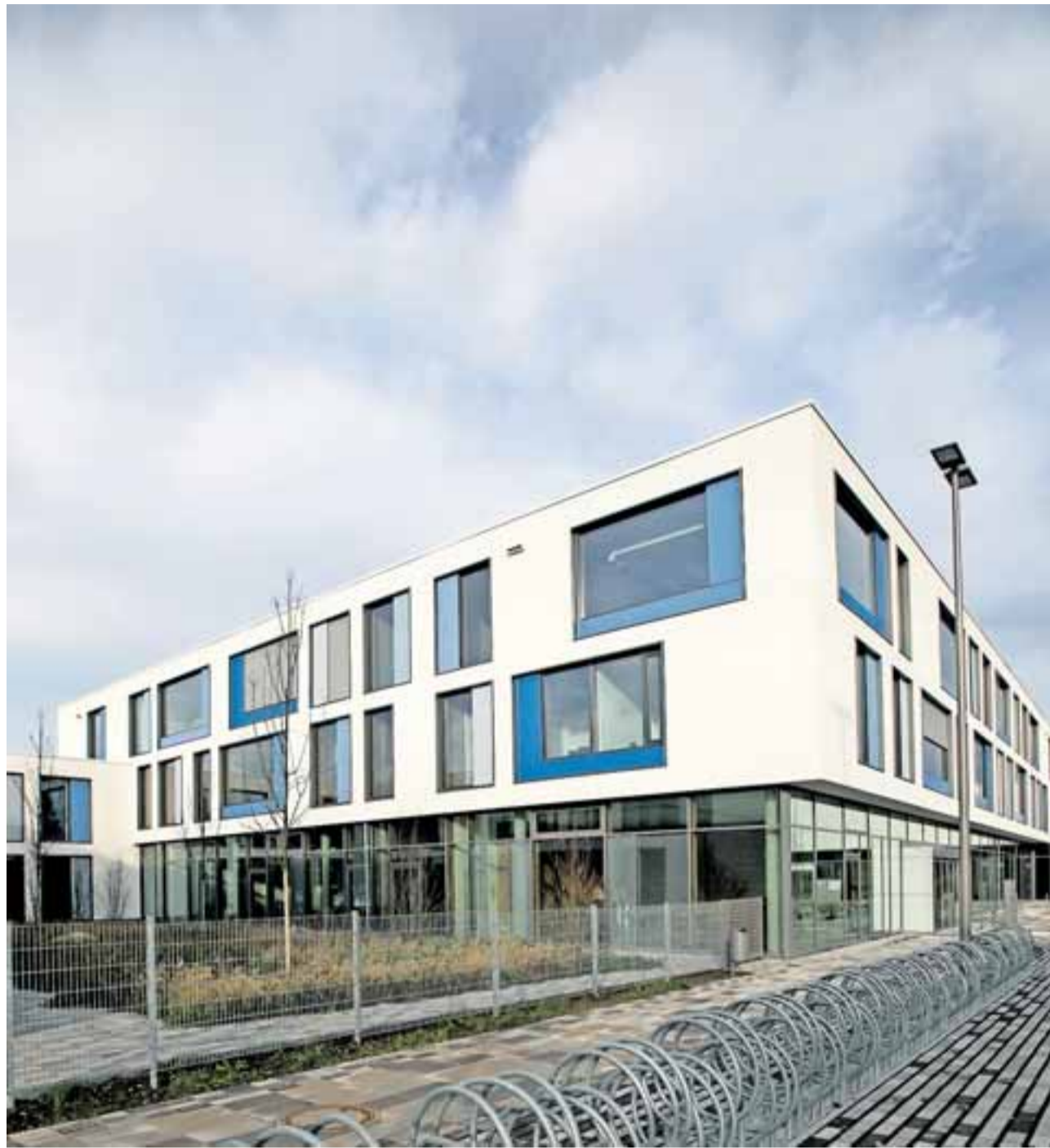
Die neue Eliteschule des Sports im Münchner Norden hat 58 Millionen Euro gekostet. Immerhin ist dieses Gymnasium so flexibel gebaut, dass die Entscheidung der CSU keine Rolle spielt.
