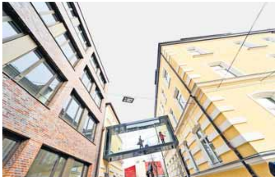
Neu ist nicht nur der Klinkerbau zur Schloßstraße hin (links): Auch die alte Verbindungsbrücke der Stadwerke wurde durch eine verglaste neue ersetzt.
