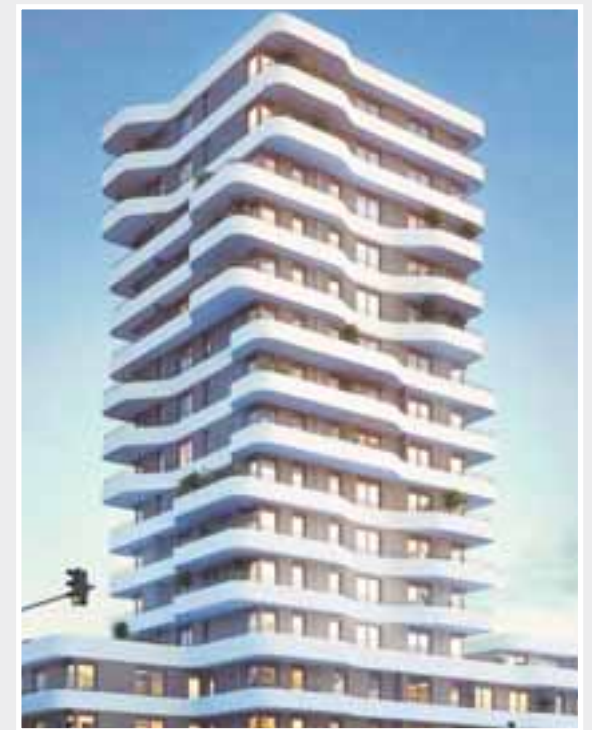
Die Bautätigkeit hat in den letzten Jahren in Ingolstadt stark zugenommen. Ein spektakuläres Projekt darunter ist der Bau des IN-Towers mit 50 Metern Höhe. Foto: Inventio Projectpartner
