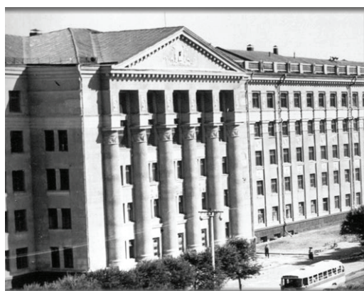
1969 г. Главный корпус ХГМИ
