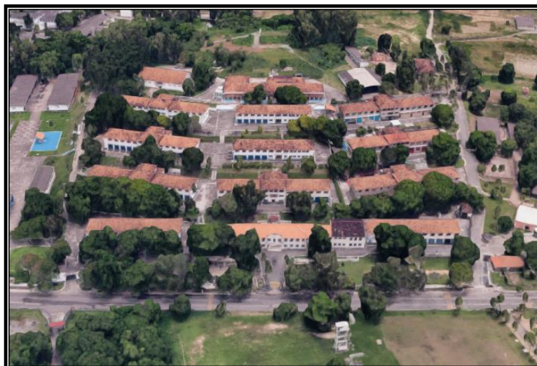
Figura 21 – Conjunto de pavilhões da artilharia. As edificações da direita, parte do grandioso projeto para a arma de artilharia, foram desmembradas do conjunto original e cedidas para a Escola de Paraquedistas. Fonte: Google Maps.
