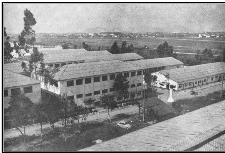
Figura 30 – Vista do Regimento Santos Dumont, 1968. Pavilhão "H" do 3º Batalhão de Infantaria Paraquedista, atualmente 25º Batalhão de Infantaria paraquedista. Ao fundo, o Campo dos Afonsos. Fonte: Revista do Regimento Santos Dumont , 1968.
