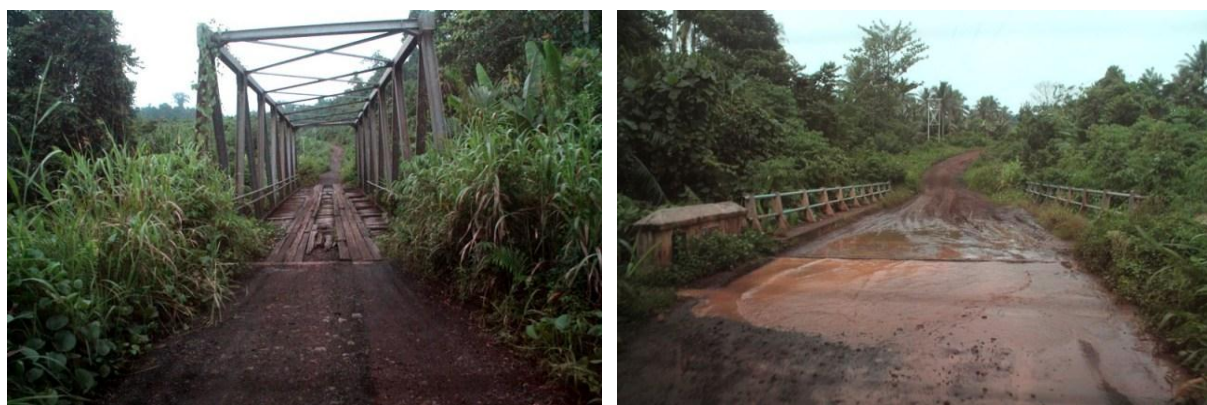
Gambar 22. Akses Jalan Menuju Desa Kai, Kec. Kao Barat, Kab. Halmahera Utara
