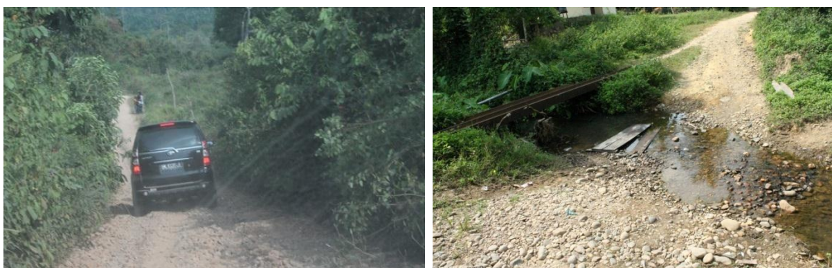
Gambar 12. Kondisi Jalan Menuju Desa Buket Makmur
