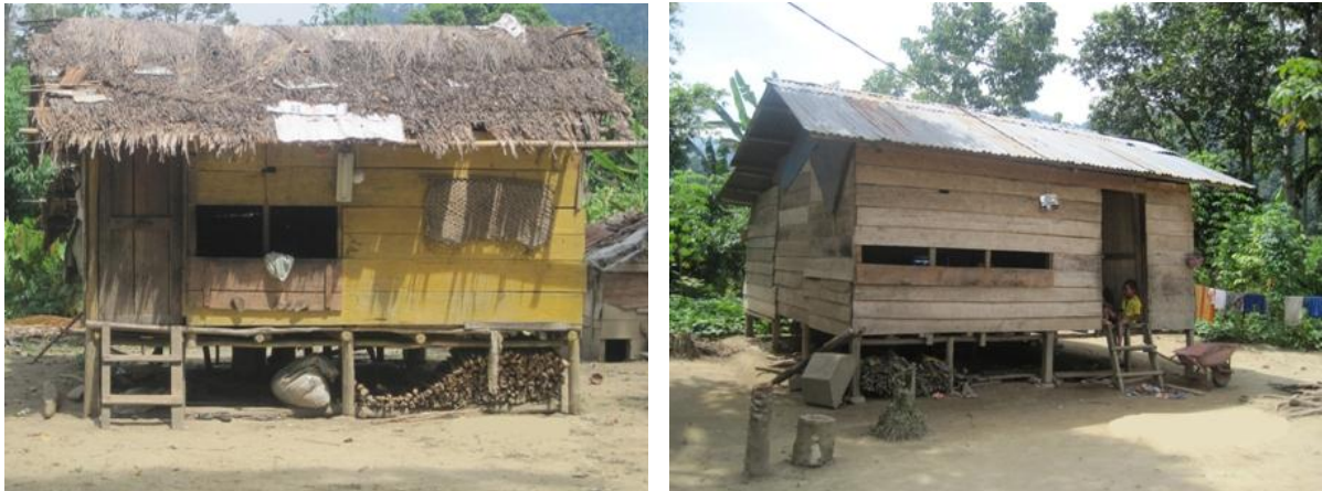
Gambar 11. Kondisi Rumah KAT Aceh Utara Sebelum Menerima Program Pemberdayaan KAT
