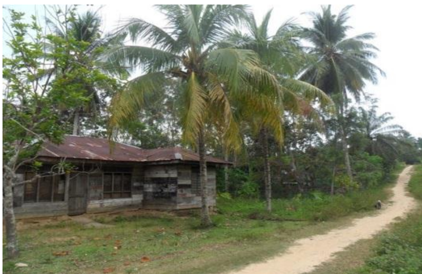
Gambar 15. Kondisi Rumah Asli Warga KAT di Buket Makmur Sebelum Mendapat Bantuan
