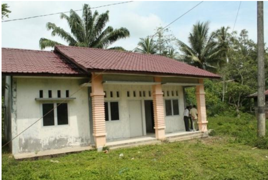
Gambar 13. Puskesmas Desa Buket Makmur Yang Tidak Terpakai Karena Tidak Ada Tenaga dan Peralatan Kesehatan
