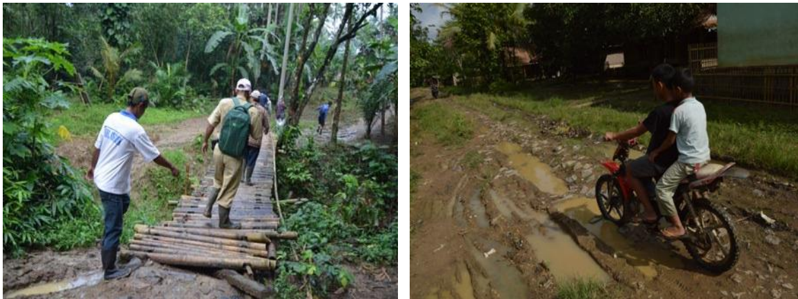
Gambar 27. Kondisi Jalan Utama Menuju Lokasi KAT di Desa Parung Kokosan
