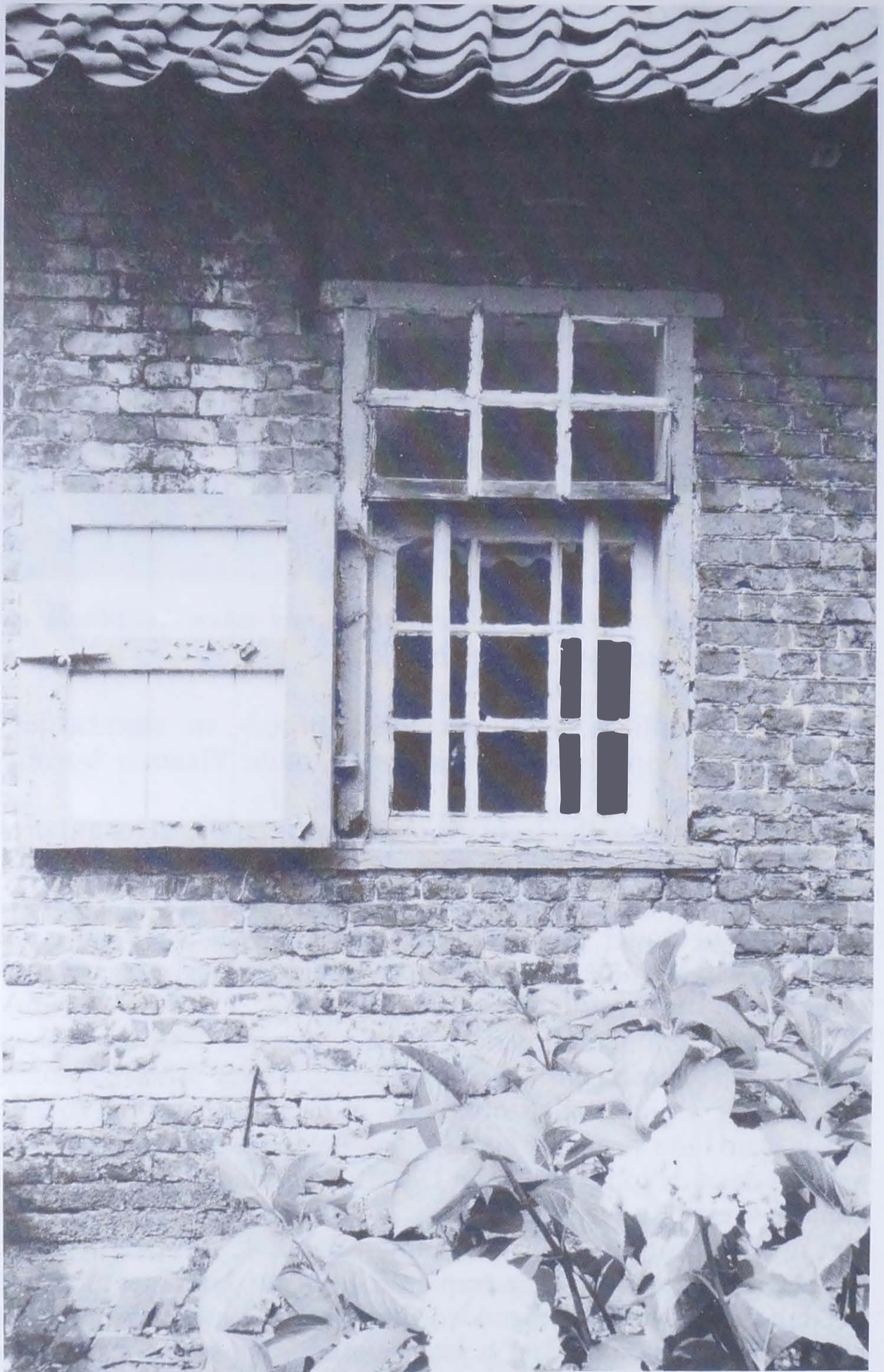
Een beluikt houten kloosterkozijn met diefijzers verlicht de achterkeuken.
