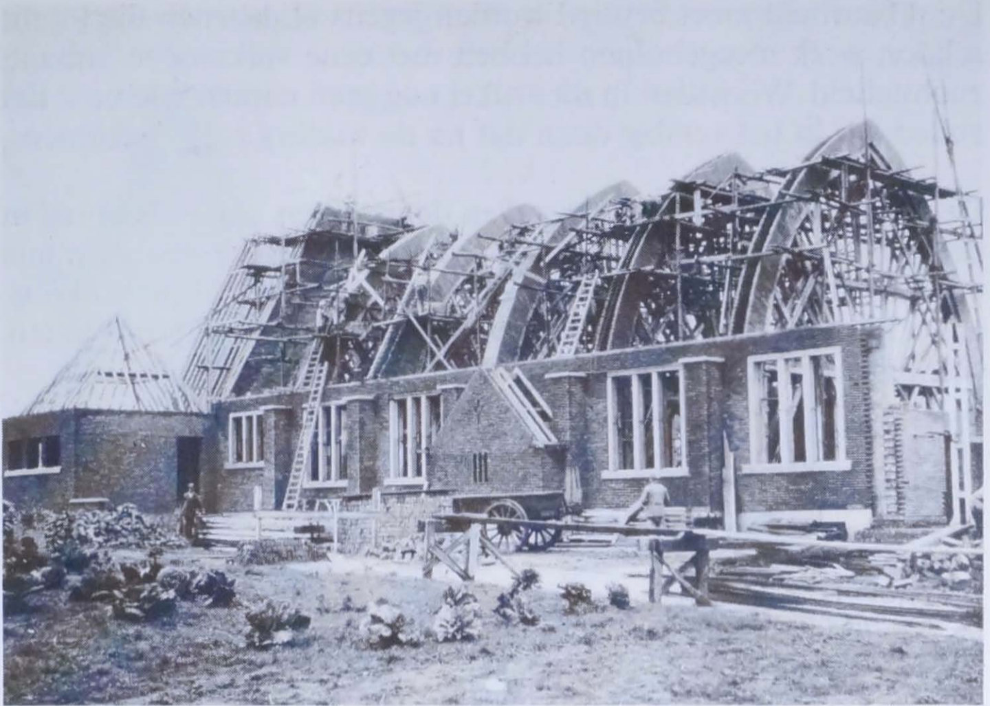
De kerk in opbouw op 22 oktober 1938. Er is nog geen spoor van de onderbouw van de toren te zien.
