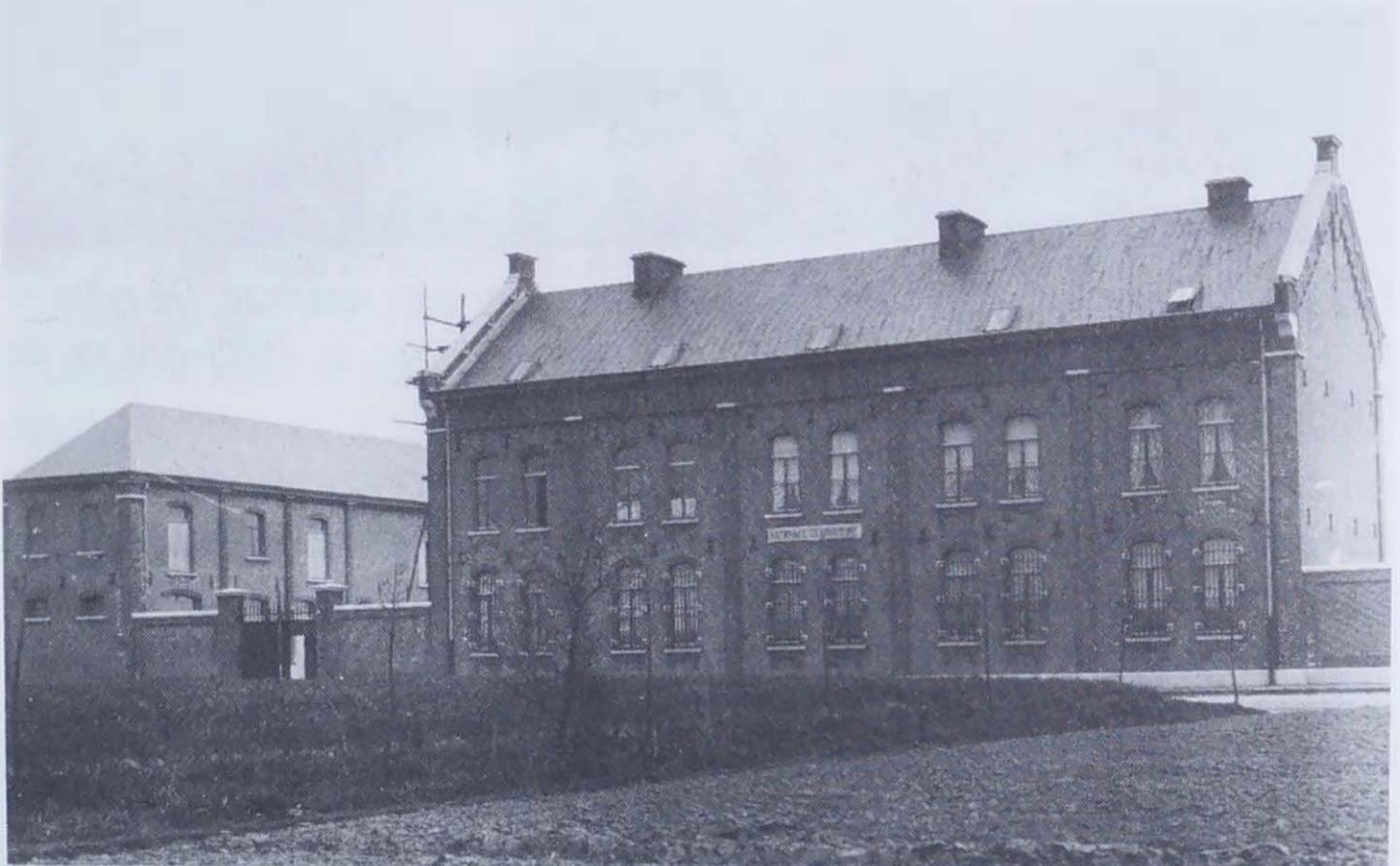
De "Nationale Gendarmerie" te Aalter vóór 1940. Het gebouw werd vernield door het bombardement van 18 mei 1940. (Copyright A.C.L. Brussel.)
