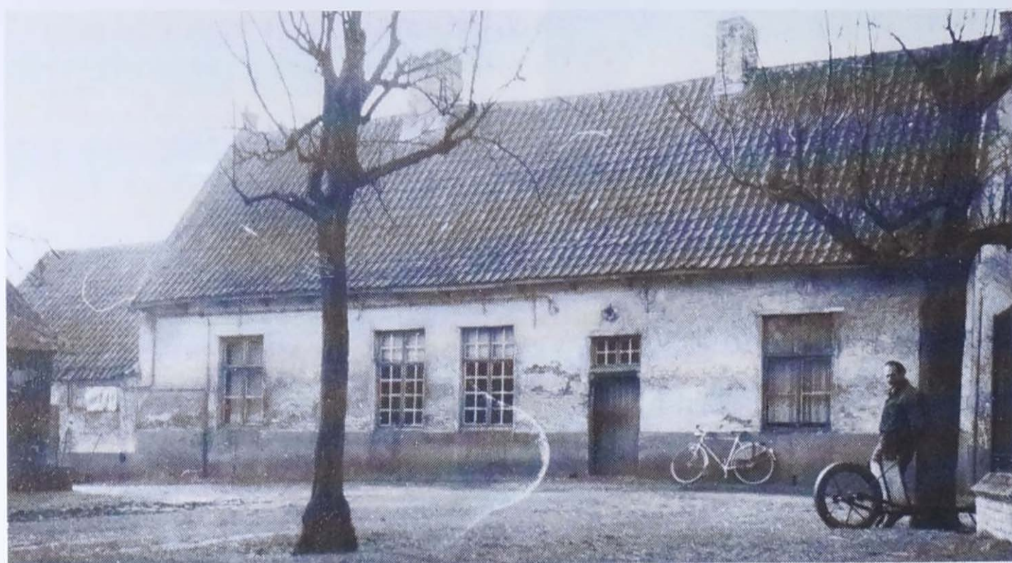
Het goed "Te Lake" waar landbouwer Karel Lootens woonde. De gebouwen werden opgericht in het jaar 1700 en gesloopt in 1969 om er de Comelco te bouwen. (Foto : M. Thys.)
