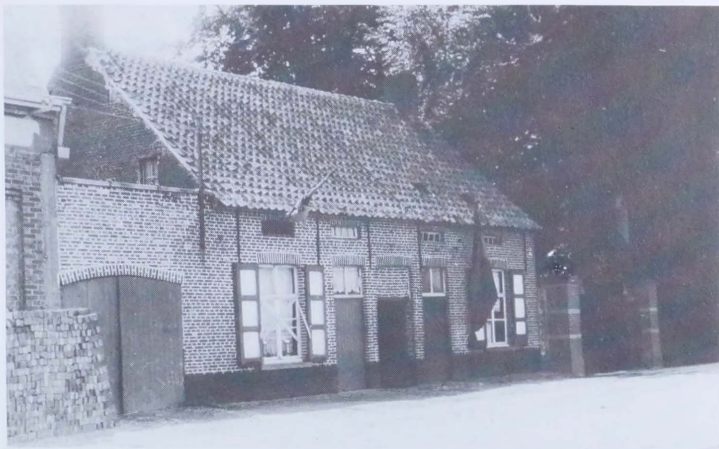
Tweewoonst staande tussen de magazijnen van Botha en de villa "Soudan", zoals die toen genoemd werd (nu Brug-Zuid nr. 19). Hier woonde Alfons Bonami en Cyriel De Graeve. Opname 1938.
