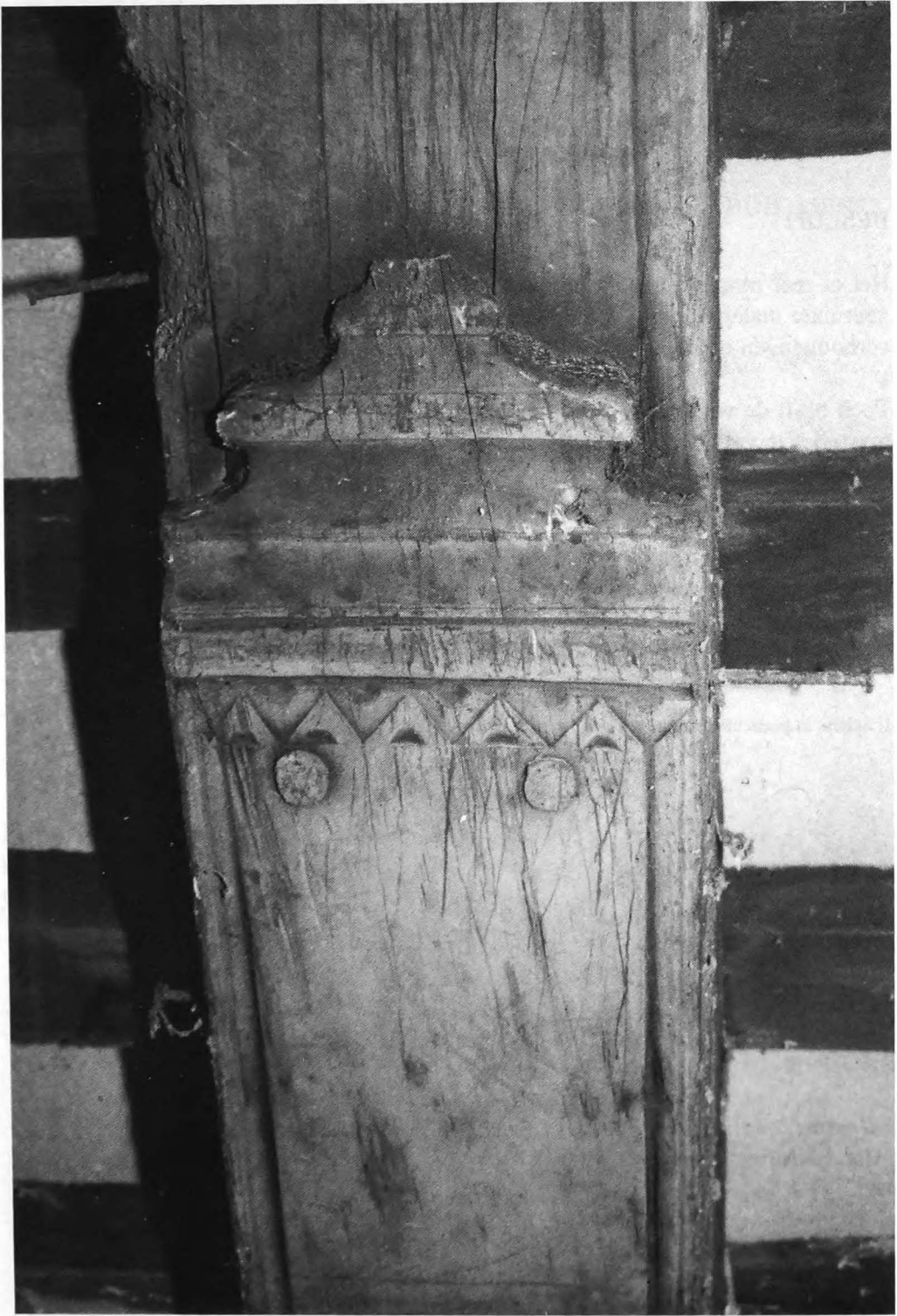
Mooie balksleutel waarbij door de twee 'pennen' de indruk wordt gewekt dat het om een 'opzetstuk' gaat.
