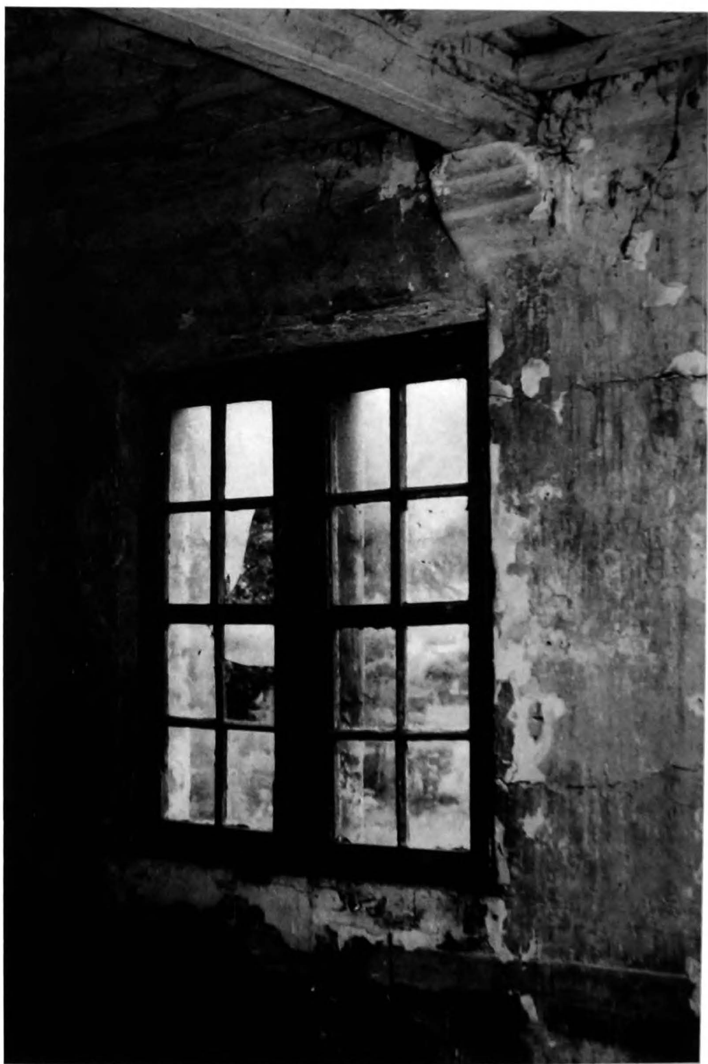
Vernieuwd raam en console onder de moerbalk.
