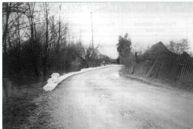
Početak izrade zečjeg nasipa u selu Lonja (izvor: Hrvatska vodoprivreda, 1994., 17, snimio B. Mužević)
