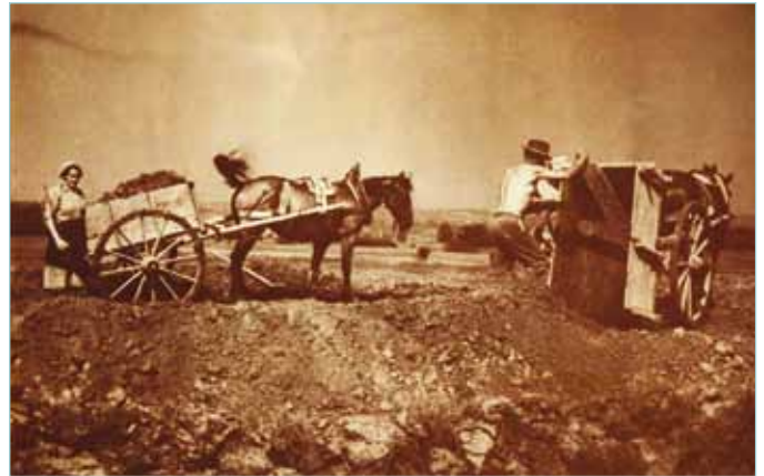
Gradnja krapinskog nasipa kordama 1954. godine
