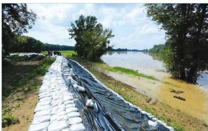
Završena sanacija nasipa u Rajevom selu 2014. godine
