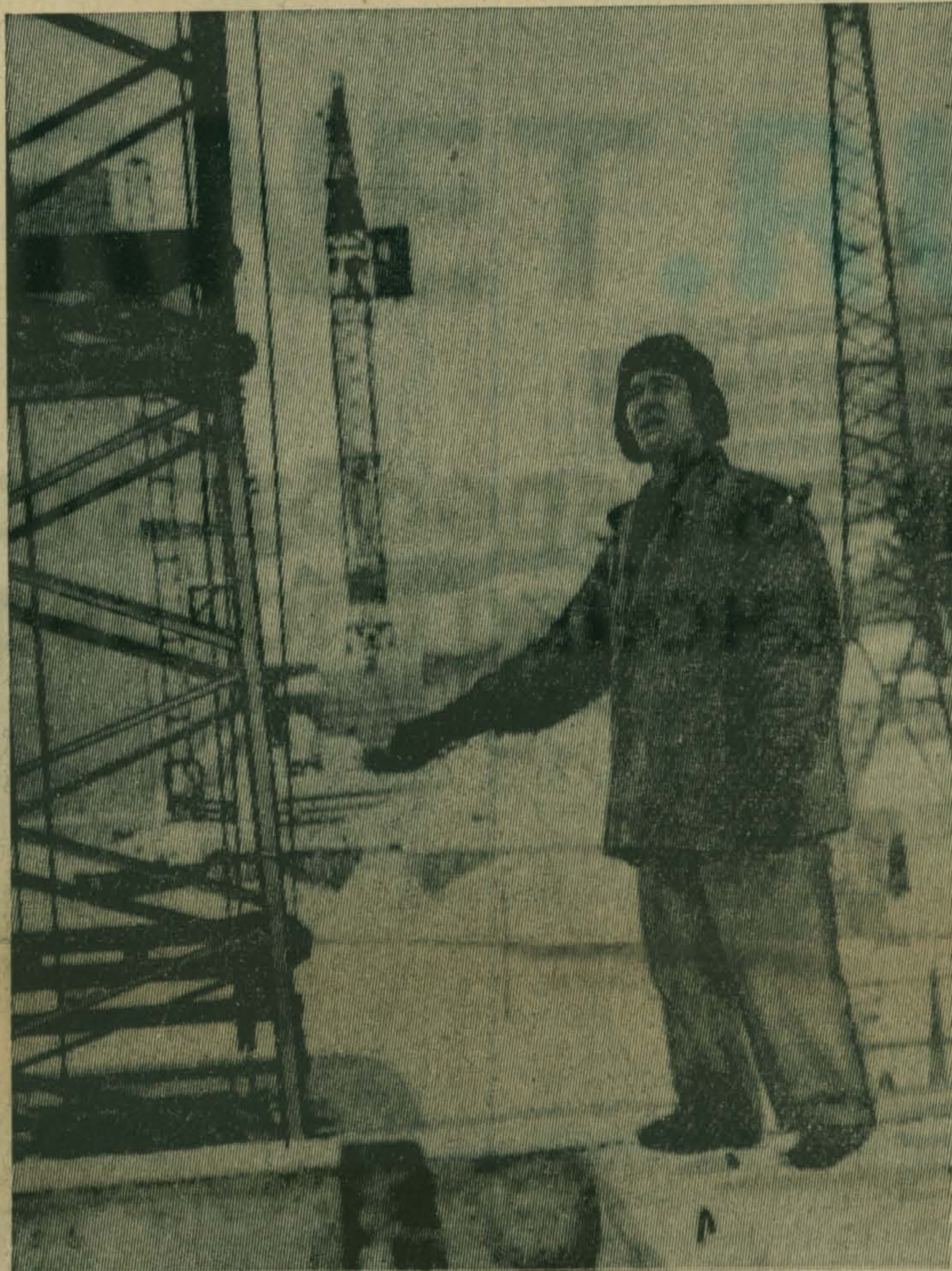
Иван Павлович Журавлев — бригадир монтажников СМУ-4 треста «Обстрой-2» и его товарищи по бригаде ведут монтаж здания районного узла связи. Выполняя свыше полутора норм ежедневно, бригада в мае-июне полностью закончит монтаж сборного железобетона и в том числе стеновых панелей.
