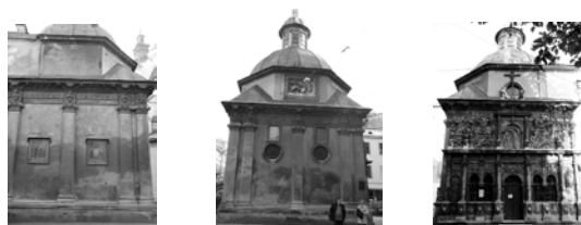
Рис. 1. Північний, східний та західний фасад каплиці
