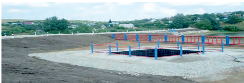
Рис. 2.40. Гидротехническое сооружение у н.п. Кызыл Байрак (Тукаевский район)
