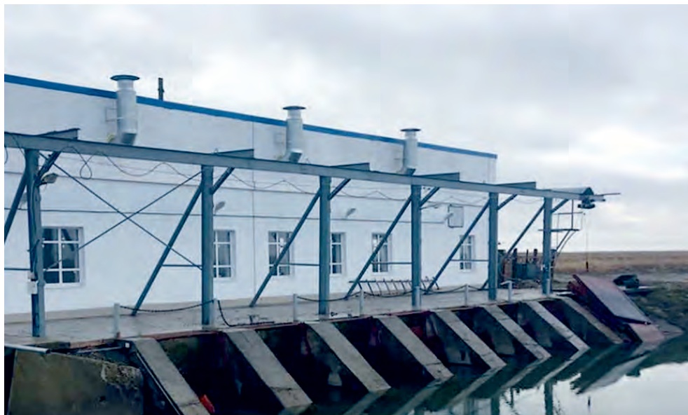
Рис. 2.23. Насосная станция № 2 Петровско-Анастасиевской оросительной системы
