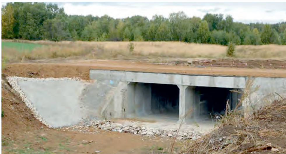
Рис. 2.31. Переезд на водохранилище Крутинковской государственной оросительной системы
