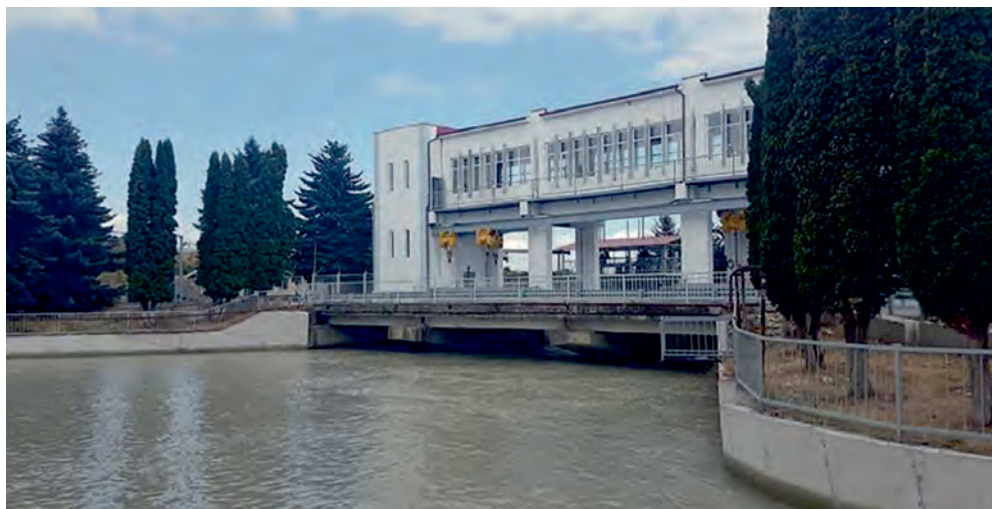
Рис. 2.21. Головной гидроузел на р. Чегем (Кабардино-Балкарская Республика)
