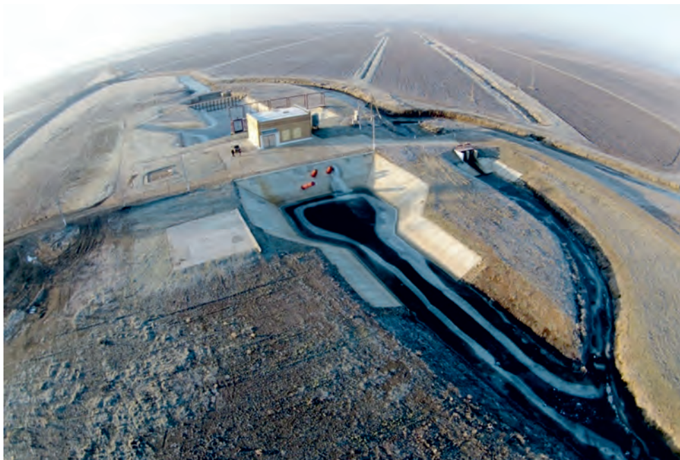
Рис. 1.9. Яхромская пойма (Московская область, Дмитровский район). Осушительная насосная станция № 4 с комплексом сооружений
