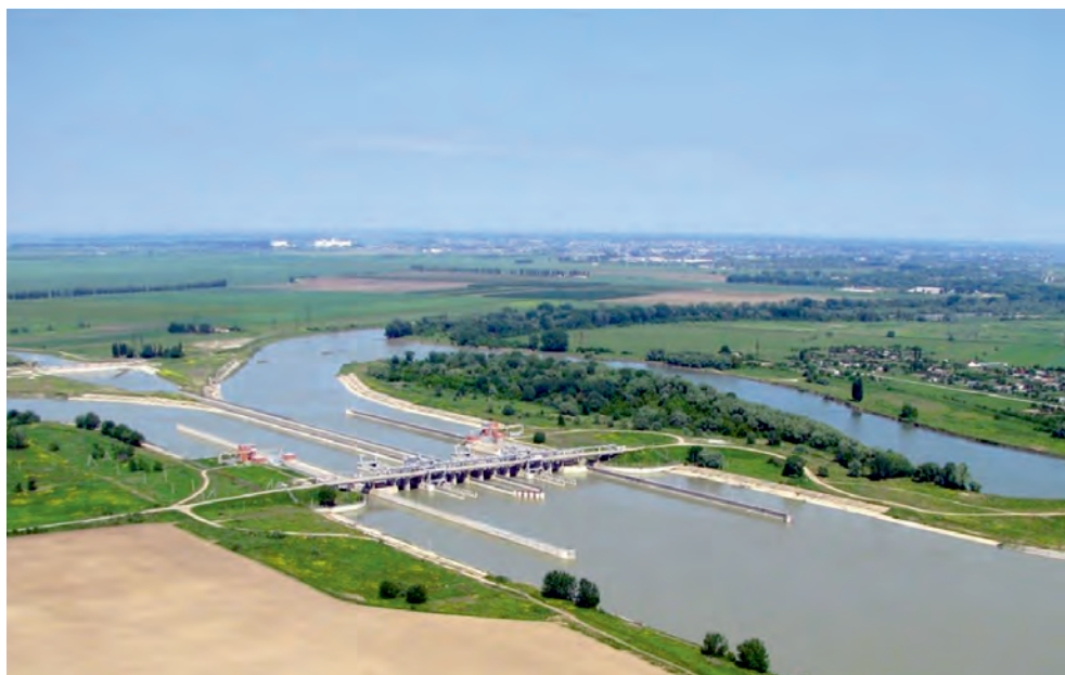
Рис. 1.6. Тиховский вододелительный гидроузел с головным водозабором на Петровско-Анастасиевскую оросительную систему
