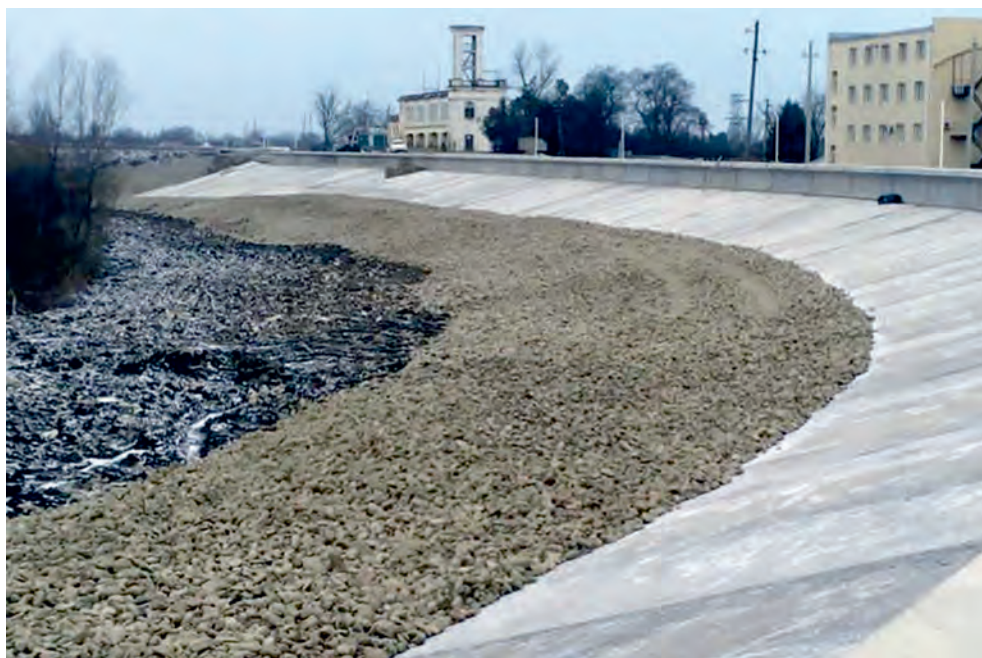
Рис. 2.20. Дамба обвалования на р. Ходзь (Республика Адыгея)
