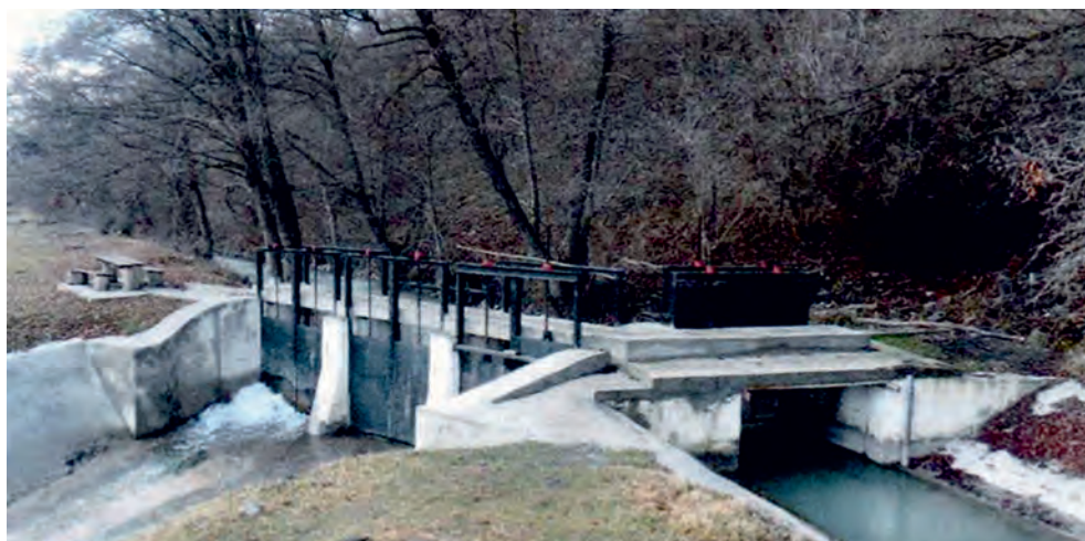
Рис. 2.42. Гидротехническое сооружение (Республика Ингушетия)
