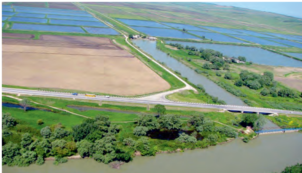
Рис. 1.5. Подводящий канал и подающие насосные станции на Темрюкскую оросительную систему
