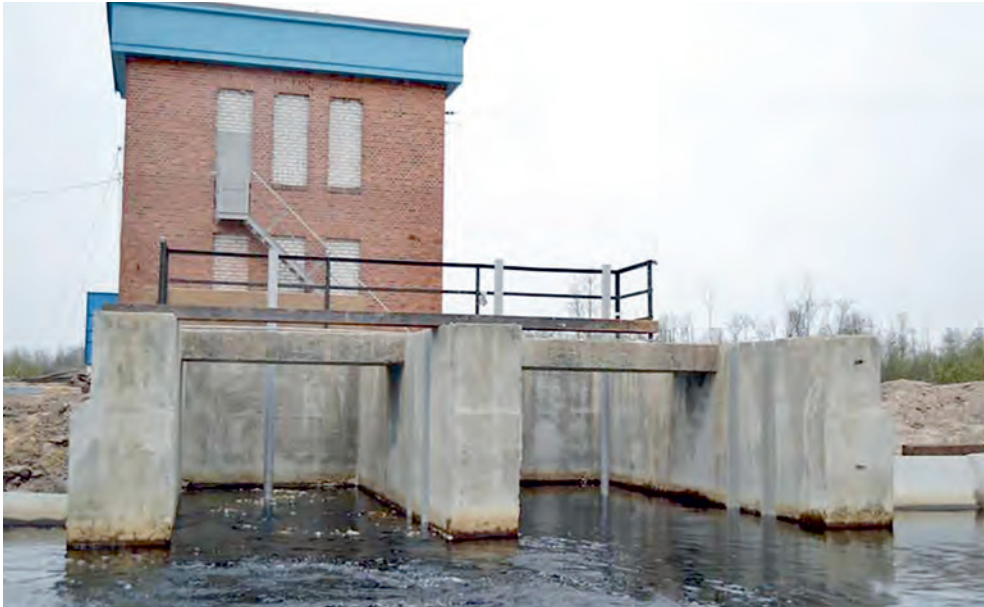
Рис. 2.17. Насосная станция № 12 магистрального осушительного канала (Калининградская область)
