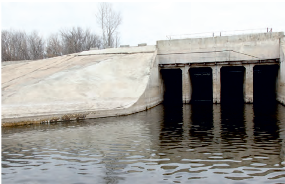
Рис. 1.10. Гидротехническое сооружение бетонной водосливной плотины на ерике Булгаков Каширинского водного тракта (Ленинский район)
