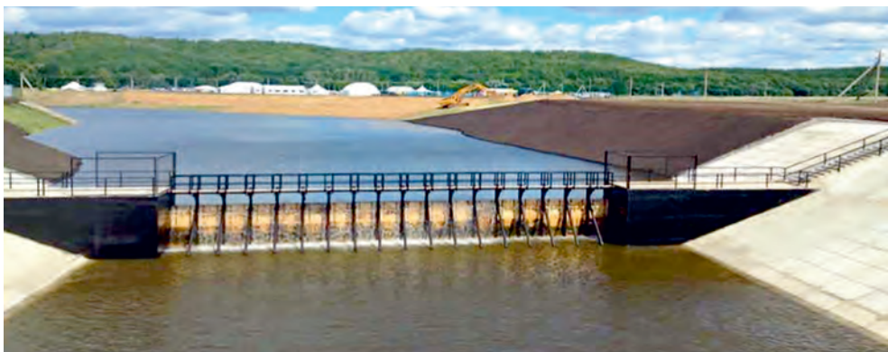
Рис. 2.39. Водоподъемная плотина у н.п. Билярск (Алексеевский район)
