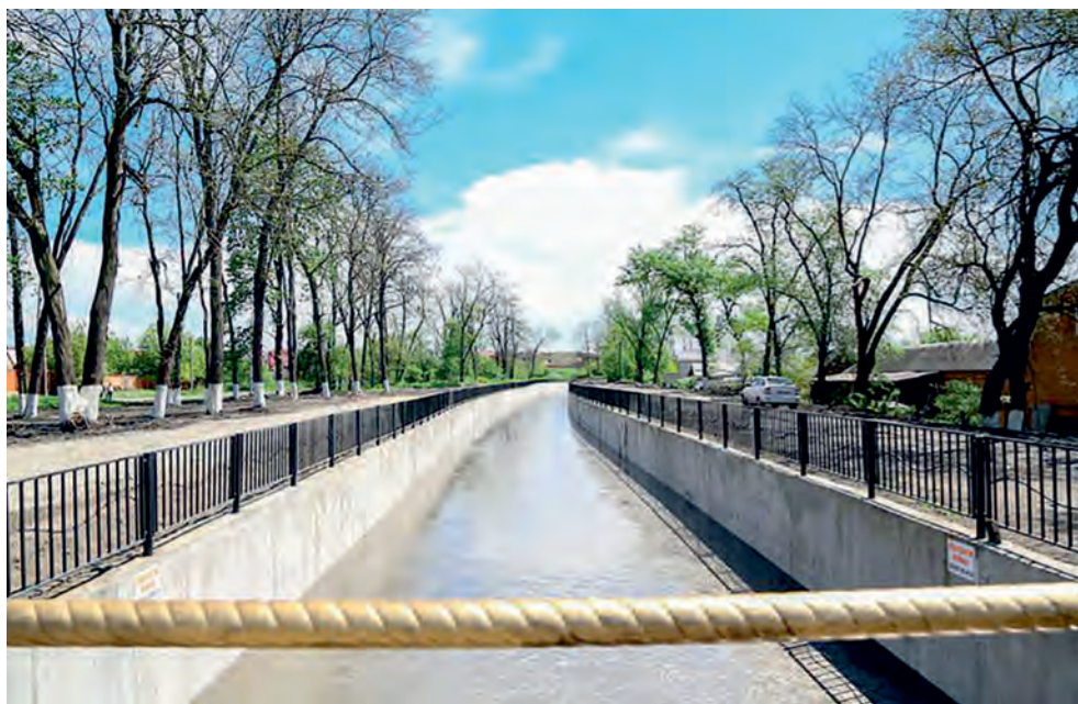
Рис. 2.12. Алхан-Чуртский канал Алханчуртской межреспубликанской обводнительно-оросительной системы
