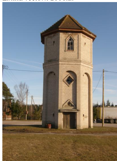
Vigala veetorn 2008.a.
