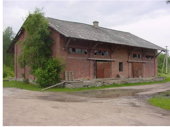
Veriora kaubaait 2004.a.(lammutatud)
