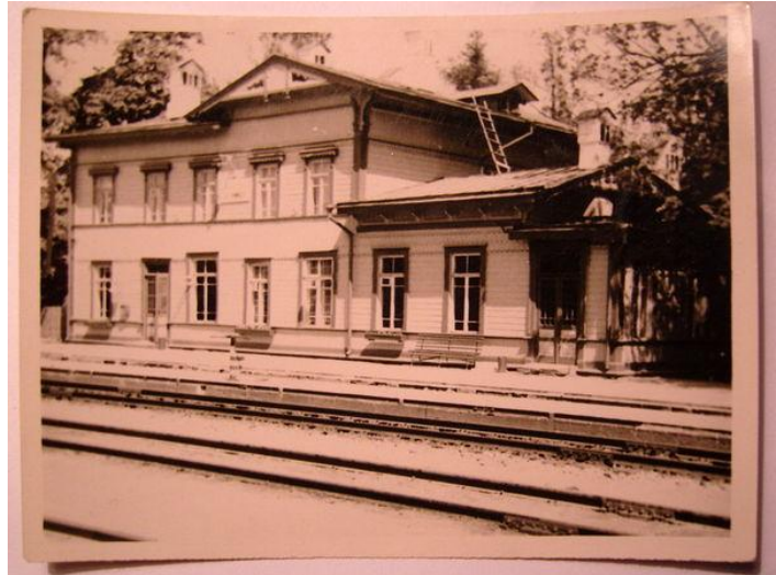
Aegviidu raudteejaam enne remonti
