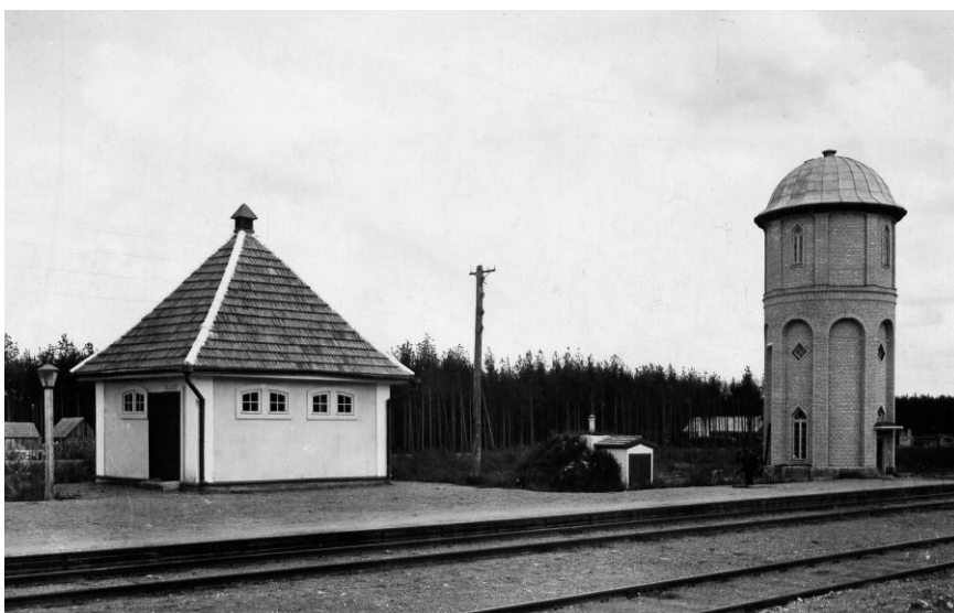
Veriora veetorn. 1932. Parikase foto.
